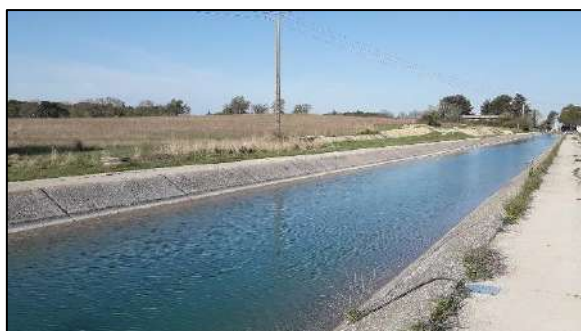
Vue du canal donnant vers l'ouest qui semble peu favorable aux chiroptères
