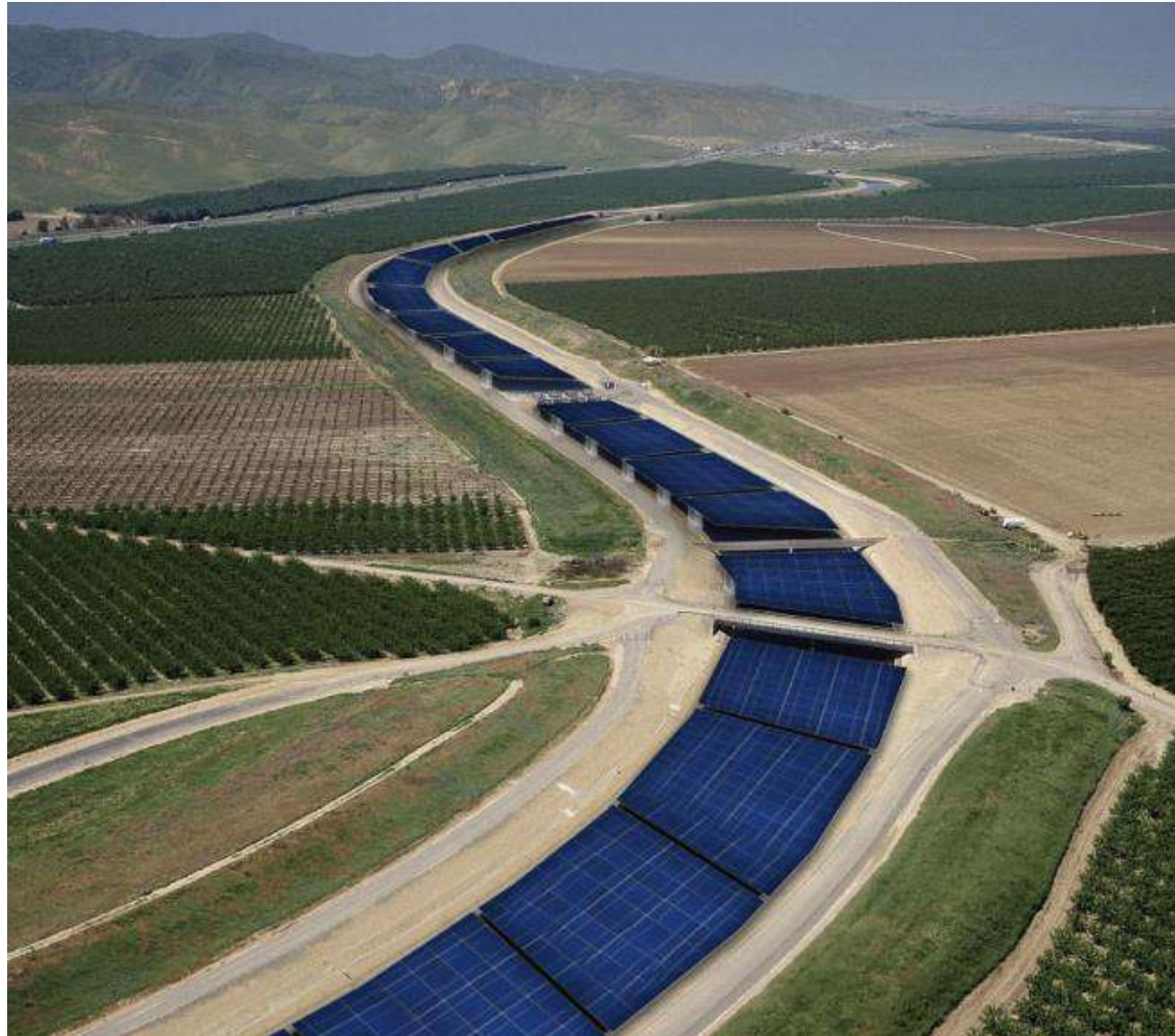
Image de référence de projet photovoltaïque sur des canaux
