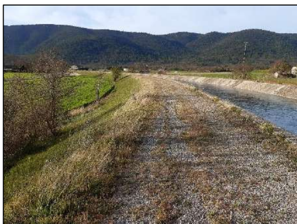
Abords immédiats du canal bétonné
