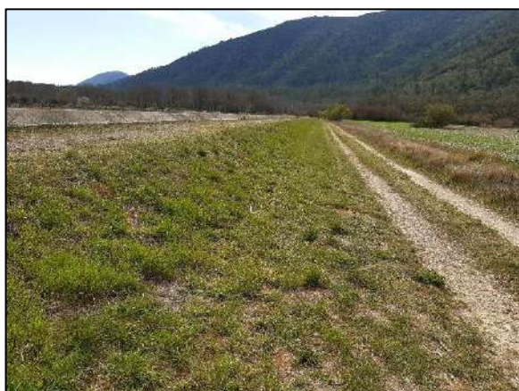
Talus, piste carrossable et canal agricole
