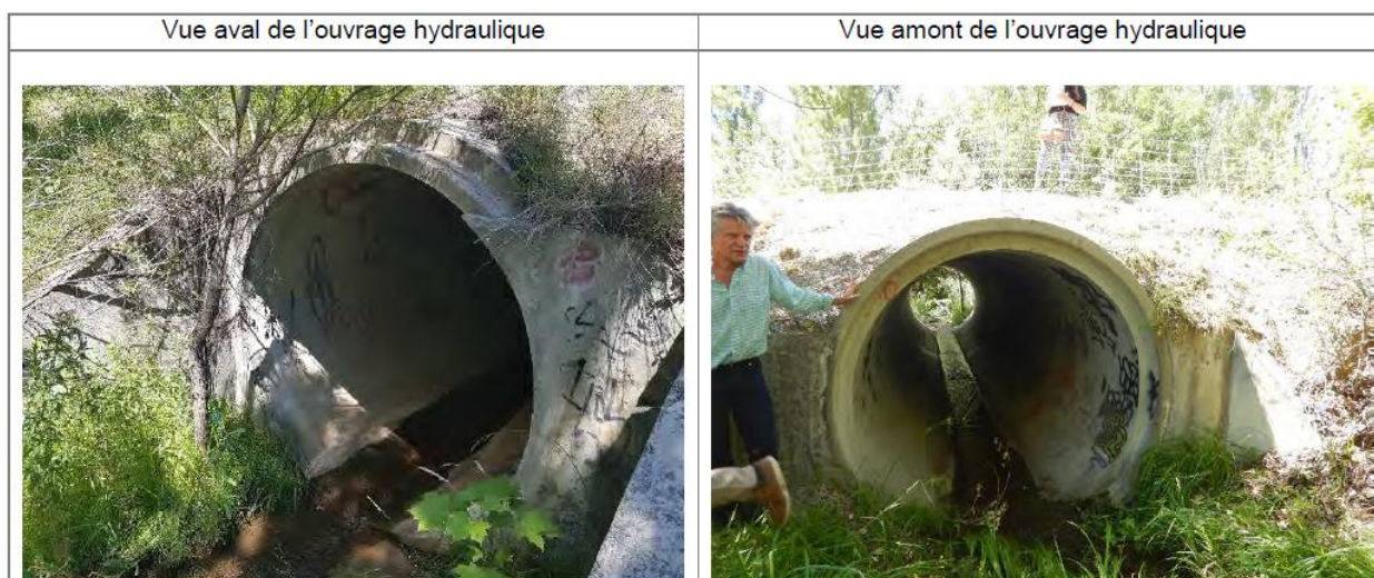
Figure 15 : photographie de l'ouvrage de franchissement OH_3 (EGIS, 2019)
