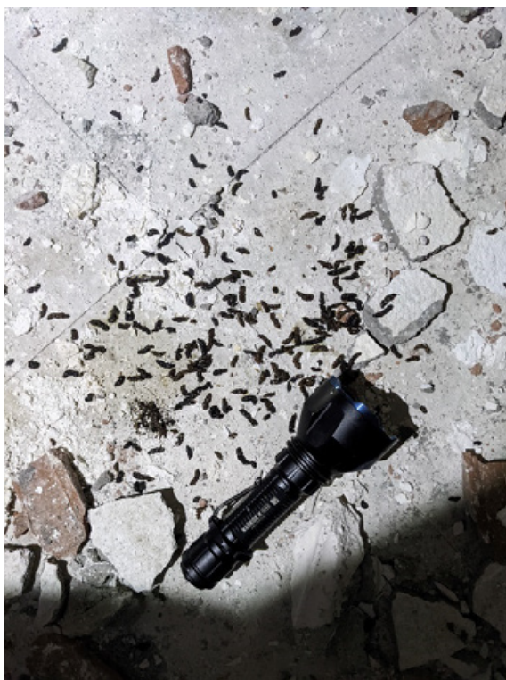
Guano dans bâtiment n°17
