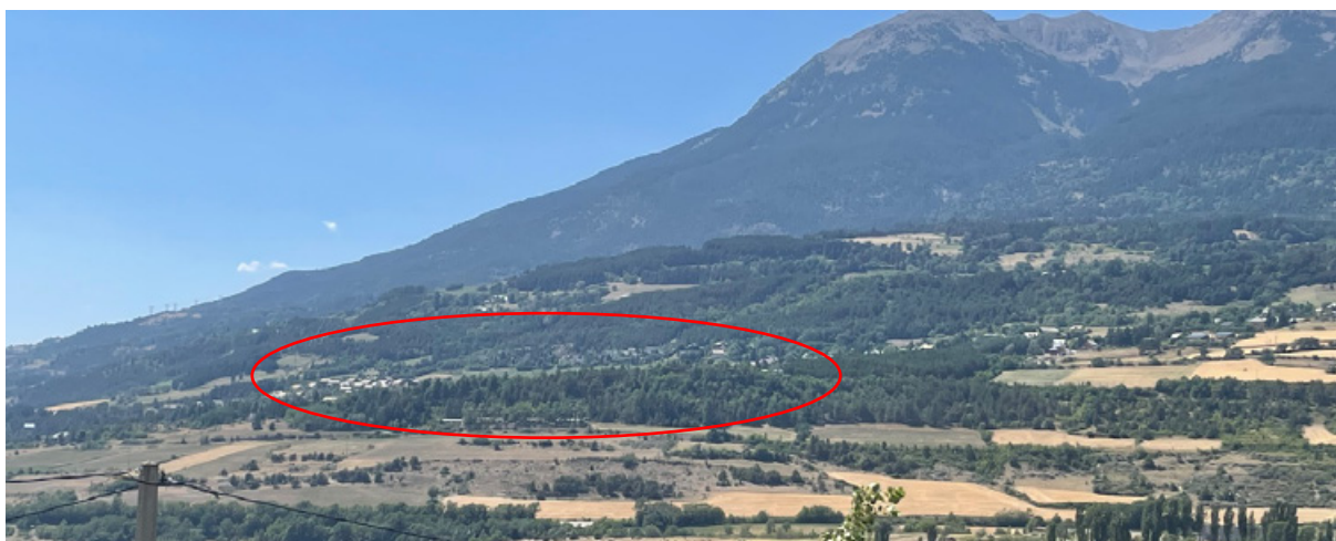
VUES A DEPUIS LES CLOZARDS (925M D'ALTITUDE) SUR LE SITE DU PROJET
