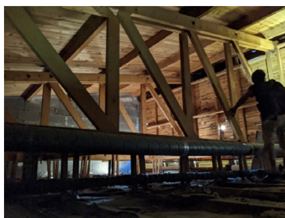
Combles du bâtiment n°6
