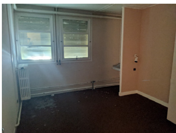
Exemple de pièce dans la bâtiment n°6
