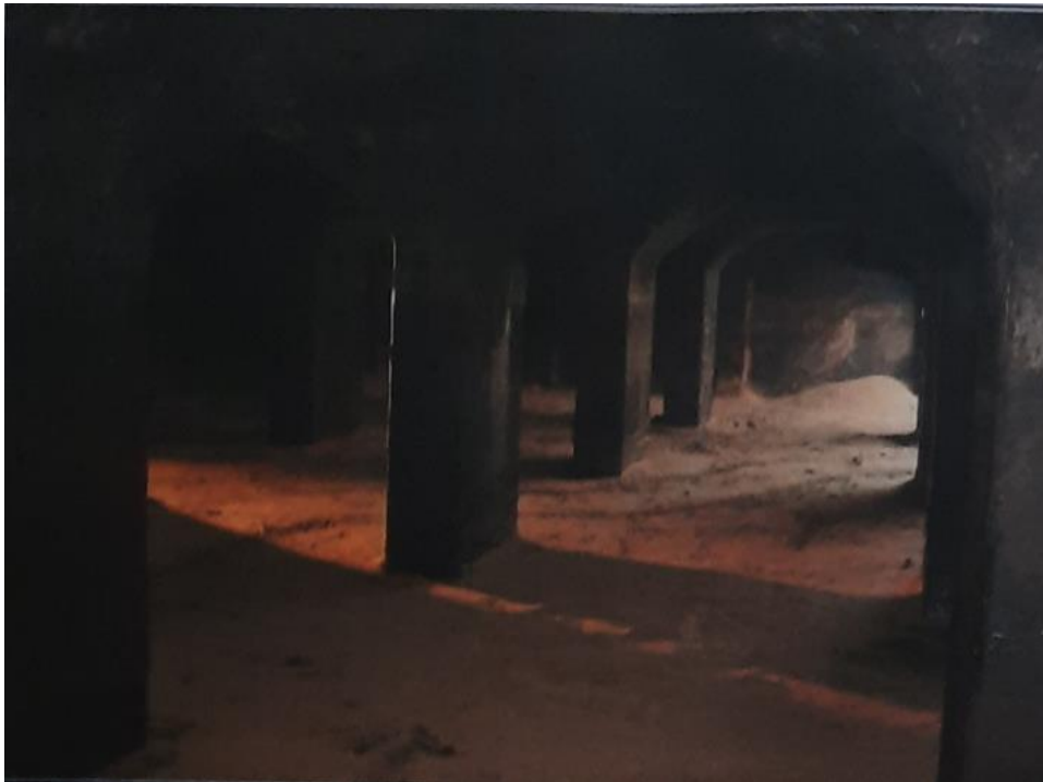
Figure 17 : Vue des piliers et des structures de la cuve C1-CA après vidange (Source : rapport EAT)
