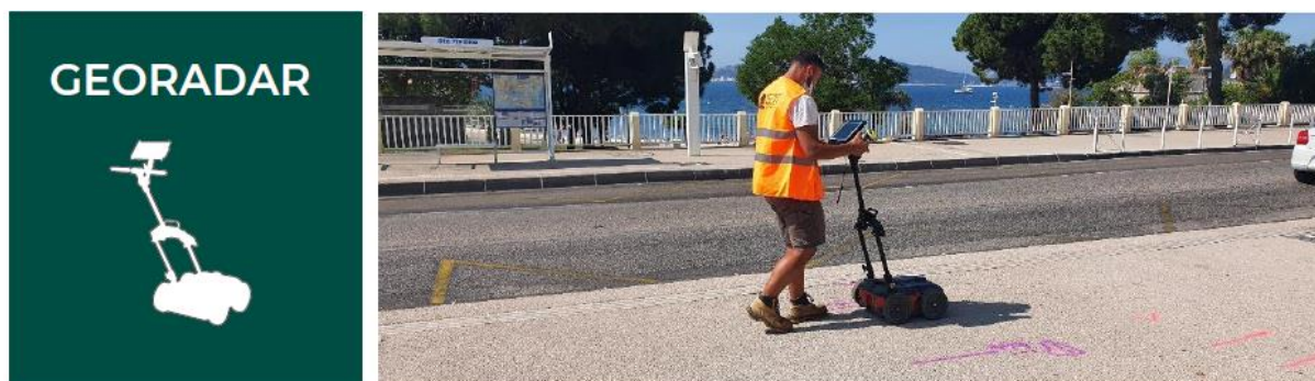
Figure 20 : Illustration de la détection des réseaux enterrés au géoradar
