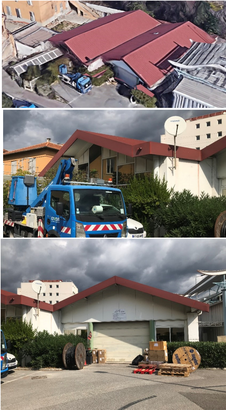
Figure 20 : Façade Sud du bâtiment
