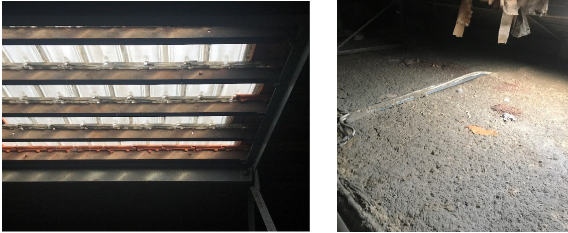
Figure 6: Isolation par laine de roche soufflée
