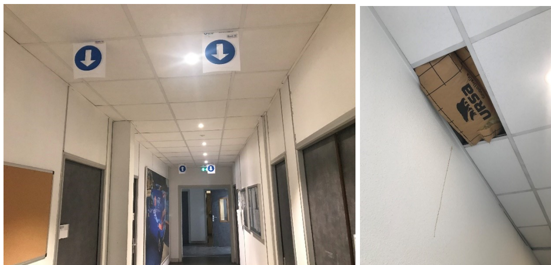
Figure 4: Circulations du bâtiment avec Faux plafonds dalles minérales et cloisons modulaires en placoplâtre revêtu. L'isolation acoustique est visible au-dessus du plafond.
