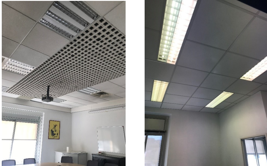
Figure 14: Bureaux du bâtiment 2
