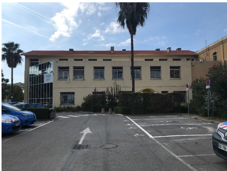
Figure 8: Façade Nord du bâtiment 1
