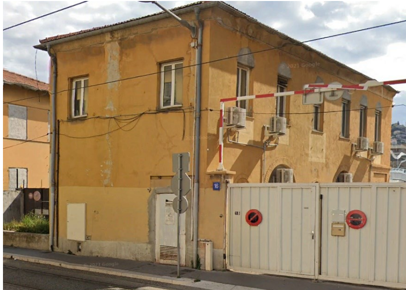
Figure 19 : Façade donnant sur route de Turin avec accès au local transformateur
