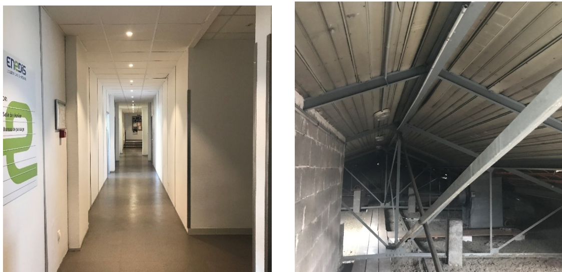
Figure 5: Comble lambrissées en sous face de la couverture tuile et charpente métallique.
