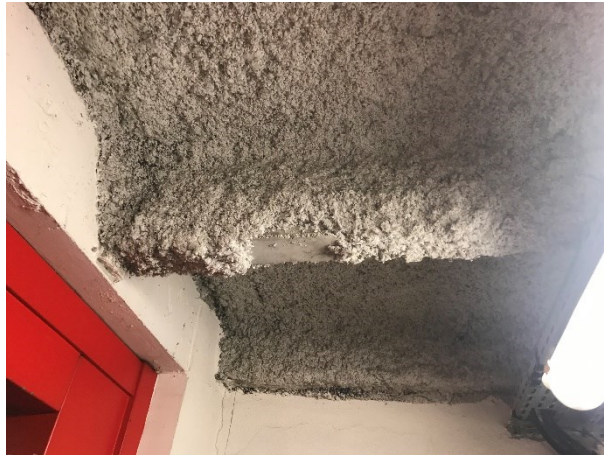
Figure 11 : Flocage du plafond du sous-sol
