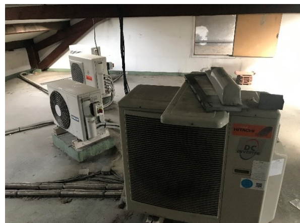
Figure 13 : Compresseurs de la climatisation réversible installé dans les combles
