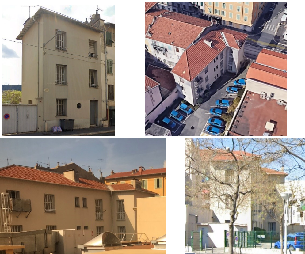
Figure 17 : Façade sur rue bâtiment 3
