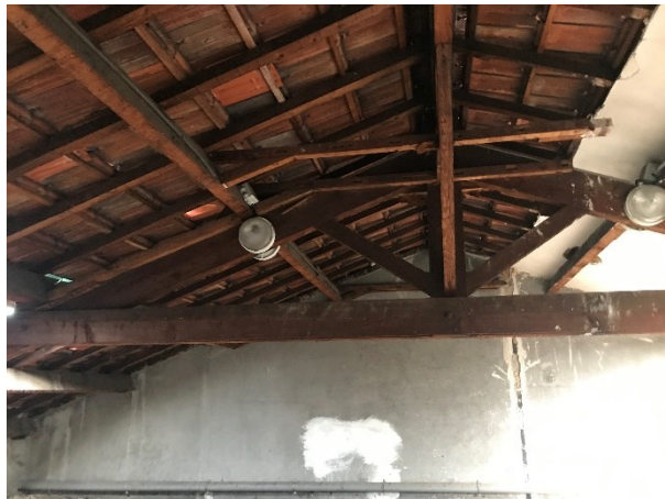
Figure 12: Charpente bois couverture tuiles et lattis plâtre
