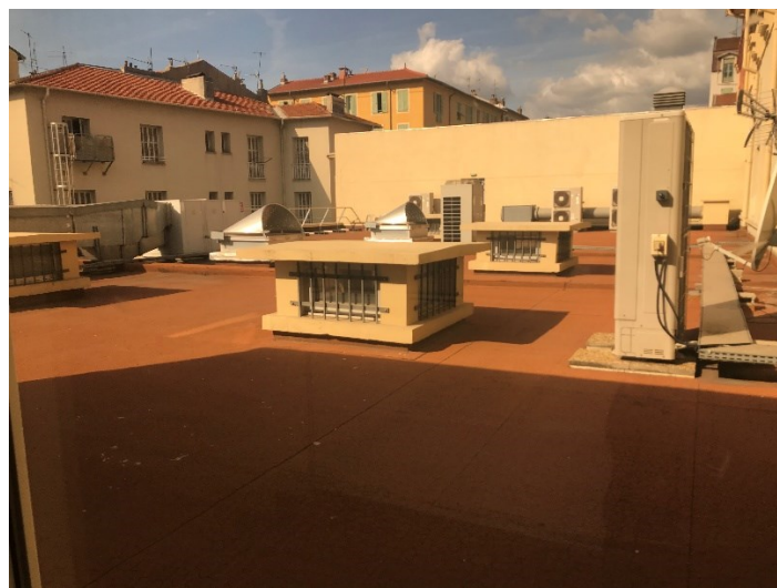
Figure 3: Toiture terrasse de l'extension Sud
