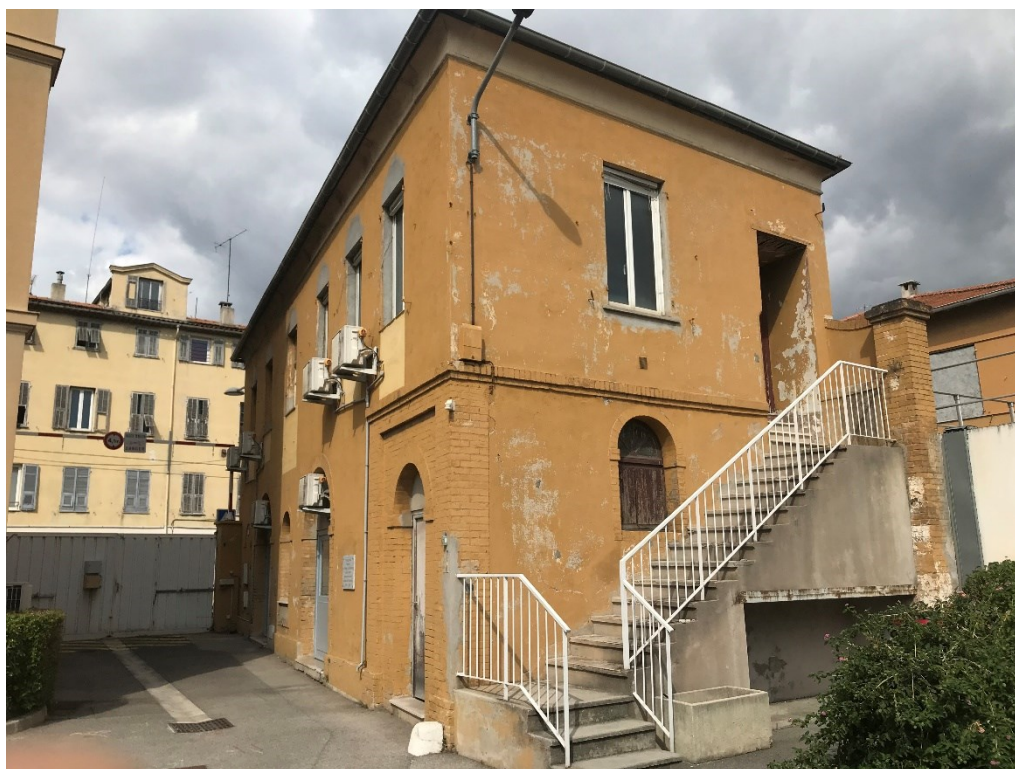
Figure 18: Façades intérieures au site du bâtiment C
