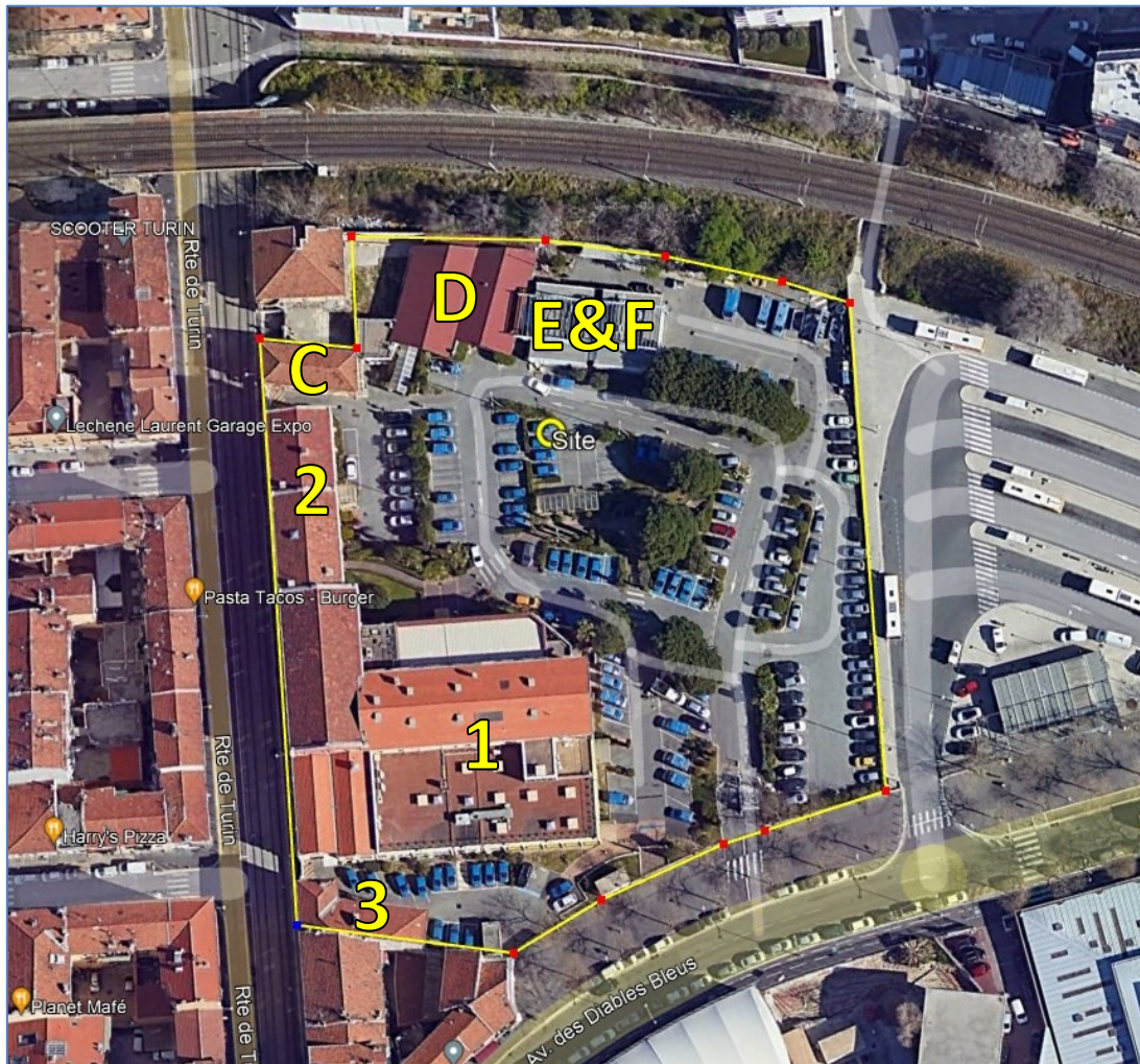
Figure 2: Photographie aérienne du site étudié et repérage des bâtiments.
