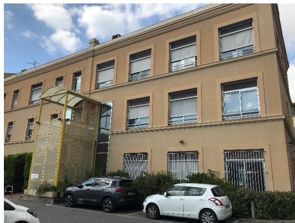
Figure 16 : Façade Est du bâtiment 2
