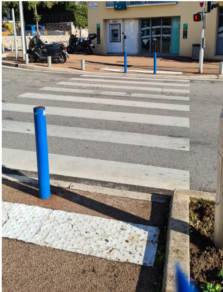
Figure 11. : Vue sur la traversée piétonne conforme de la branche Flirey, place Commandant Gérôme
