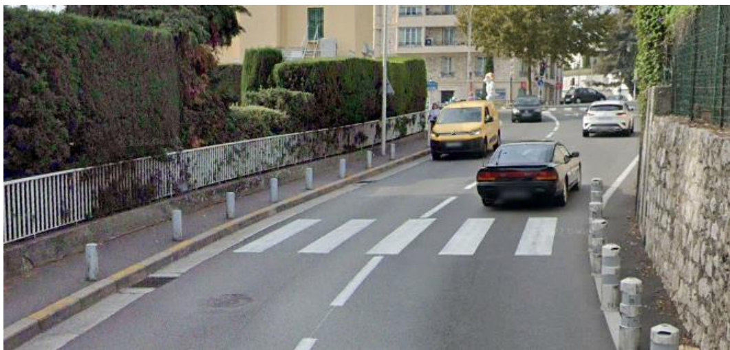
Figure 12. : Vue sur la traversée piétonne non conforme avenue de Valombrose
