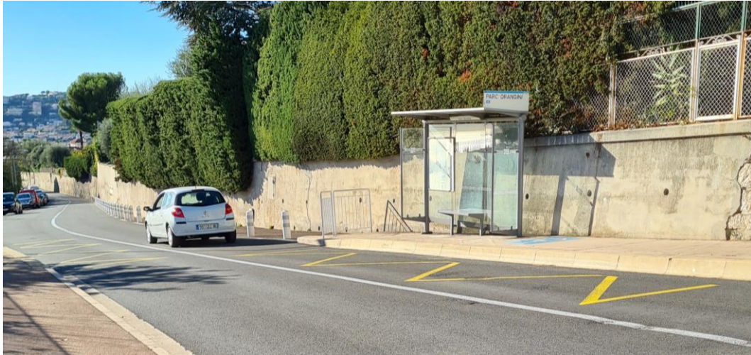
Figure 8. : Fin du trottoir au niveau d'un arrêt de bus avenue de Brancolar
