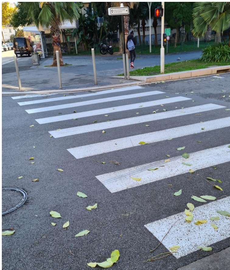
Figure 15. : Vue sur la traversée piétonne conforme du carrefour à feux Av Lépine
