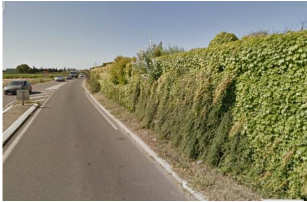
Ecran végétalisé avec mur béton
