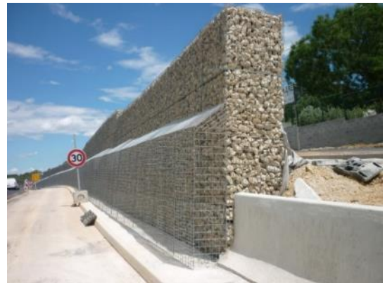
Ecran en gabions
