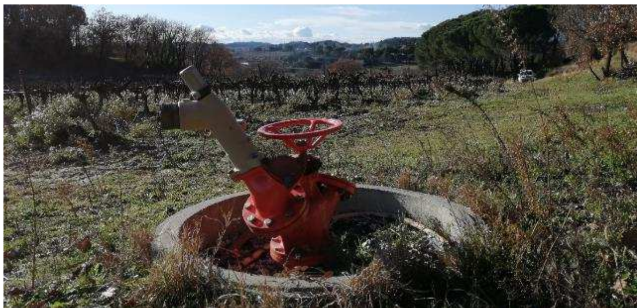
Figure 1. Exemples de chantier de pose de canalisations enterrées en zone agricole et de petits ouvrages associés (SCP, 2012 – 2020)
