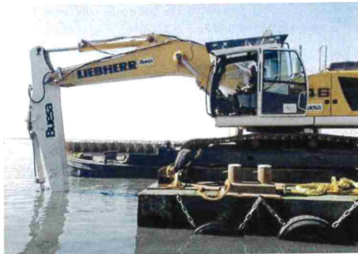
Figure 2 : Atelier ponton pelle utilisé au Mourre Blanc en 2017 (CISMA Environnement, 2017)
