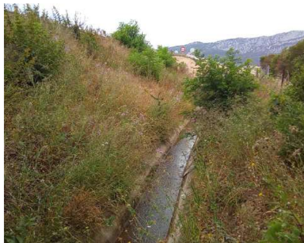
Photo 3 : Cours d'eau canalisé
