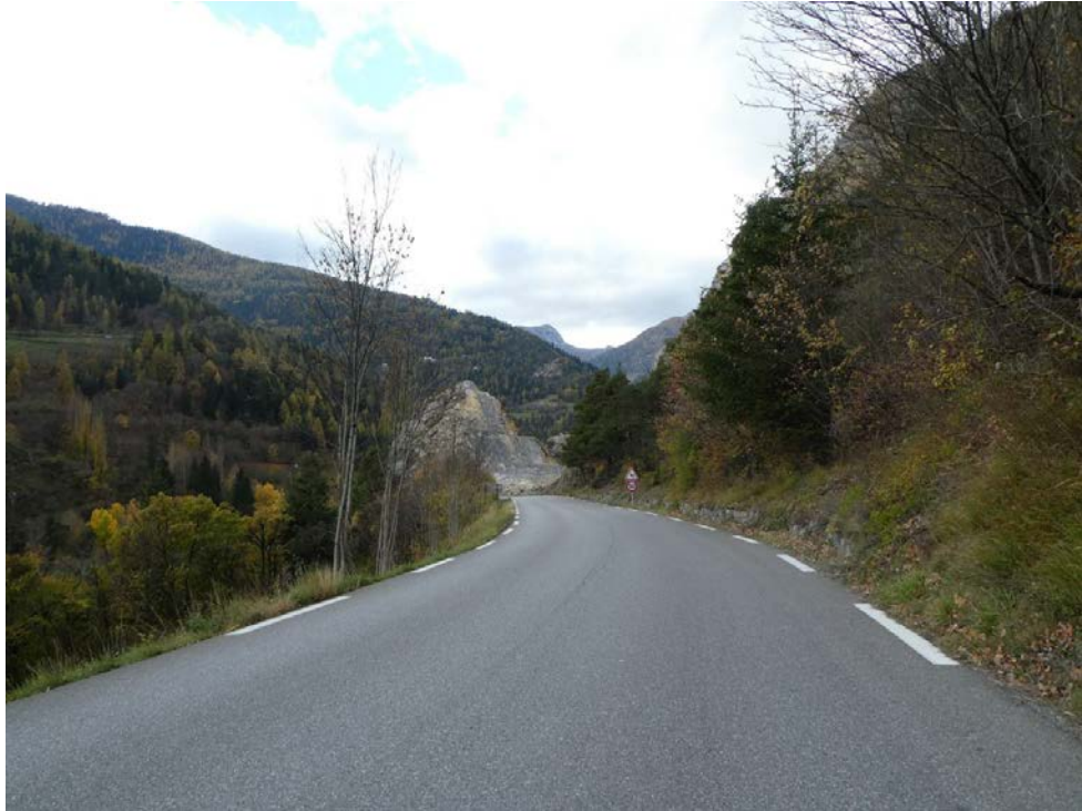
Photo 4 – Depuis la RD900 le regard vers l'ouest
