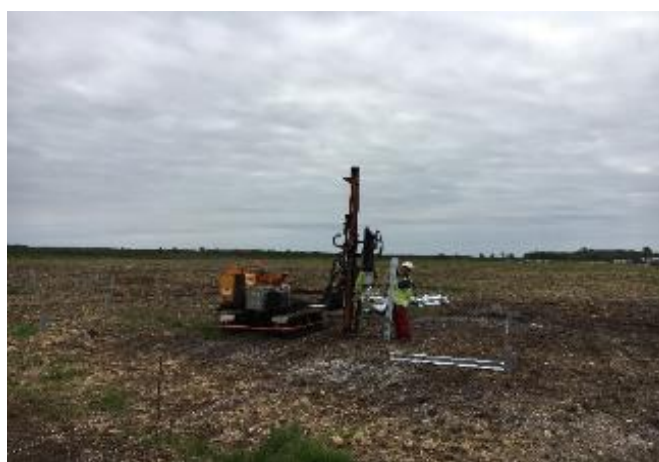
Figure 11 : battage des pieux sur une centrale photovoltaïque BayWa r.e. (source : BayWa r.e.)
