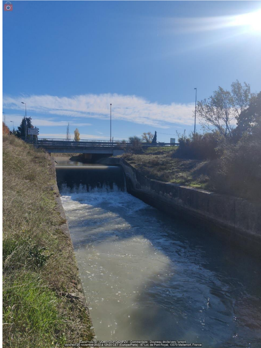
Photo 4 : Chute et site vue vers l'amont rive gauche
