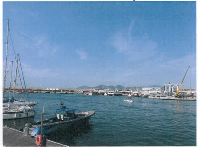
Photo 10 : vue sur la zone d'étude depuis la jetée Albert Edouard
