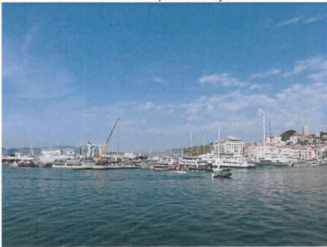
Photo 9 : vue sur la zone d'étude depuis la jetée Albert Edouard
