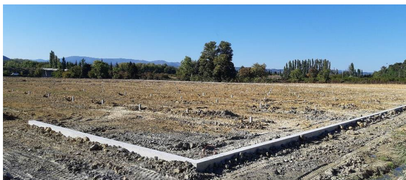
Figure 21 - Fondations béton extérieures (longrine). Source : Reden Solar.
