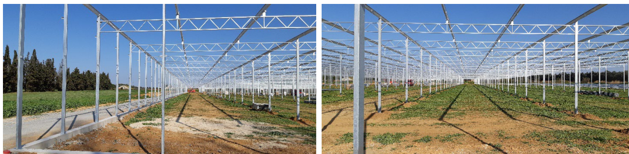
Figure 19 - Montage structure d'une serre photovoltaïque. Source : Reden Solar.
