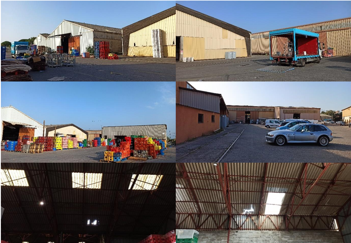
Photo 1 : Zone d'activité du secteur d'étude avec hangars et zones de circulation (Even, Octobre 2022)
