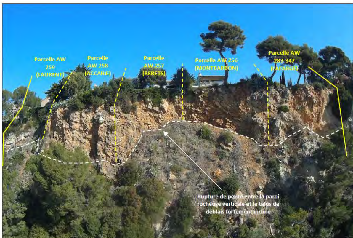
Figure 5 : Vue panoramique de la falaise côté Est
