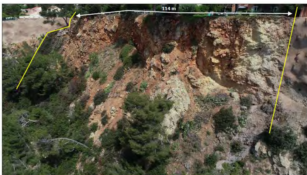
Figure 6 : Vue panoramique de la falaise côté Est
