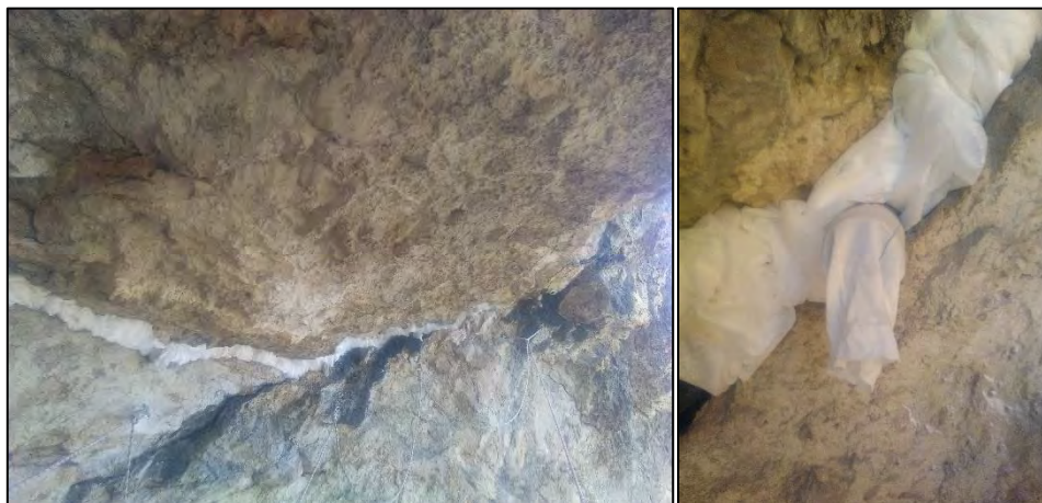
Utilisation de géotextile pour le bouchage de longues fissures, avec pose de dispositifs anti-retour (photo de droite)
