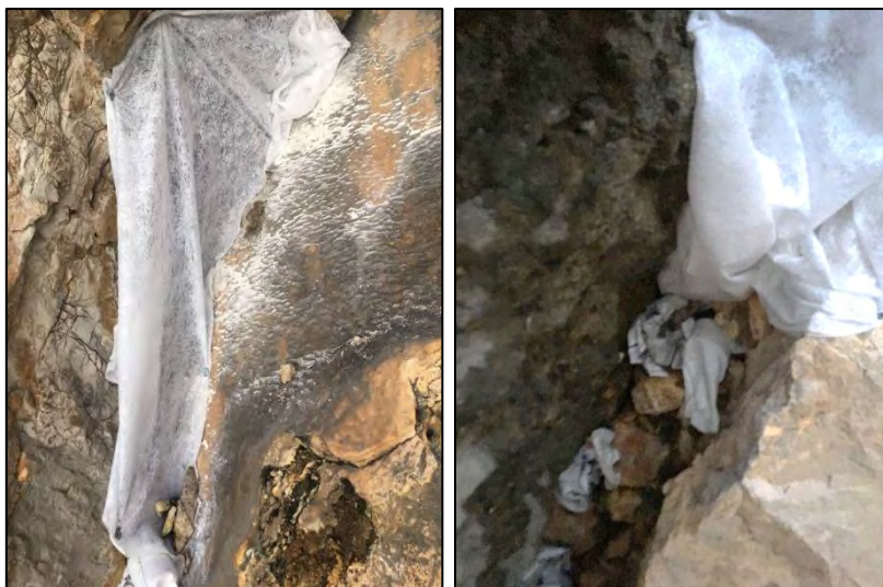
Géotextile tendu et fixé par des rivets sur les fissures les plus larges, avec dispositif anti-retour (photo de droite)
