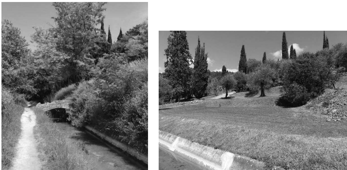
Figure 23. Différence de gestion des bordures du canal de la Siagne entre secteurs communaux (à gauche) et privés (à droite), prises durant l'ABC © L. Chevallier & A. Syx – CEN PACA
