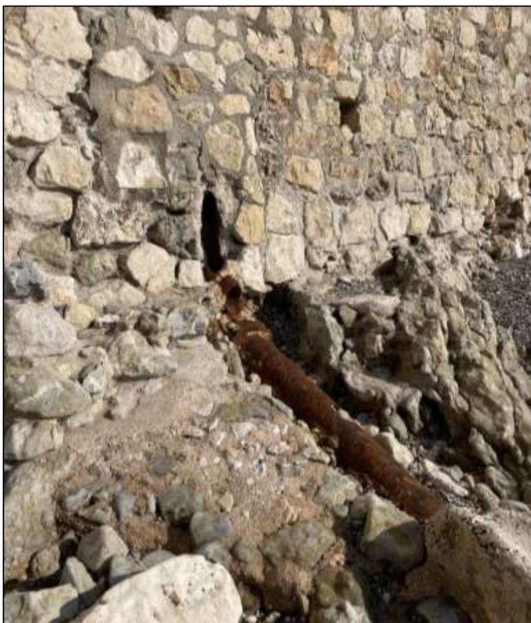
Photographie 7 : Rejet pluvial (Sud) existant sur le DPM
