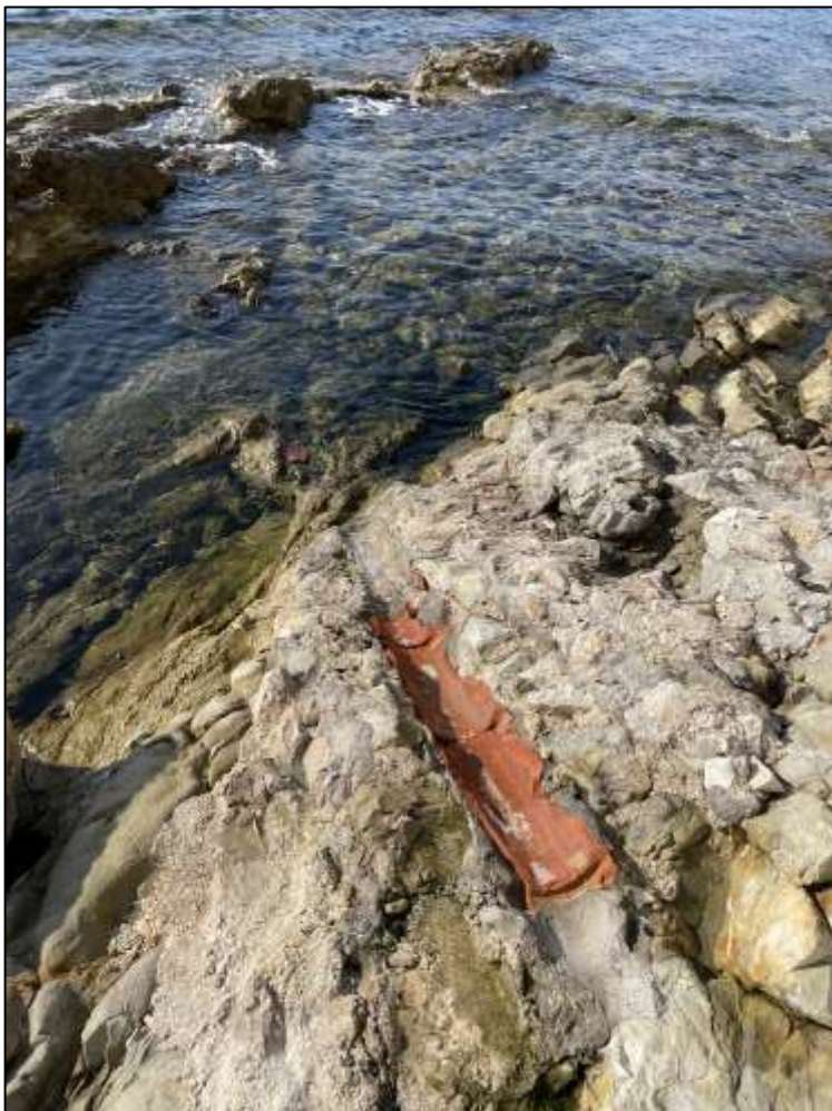
Photographie 6 : Rejet pluvial (Nord) existant sur le DPM
