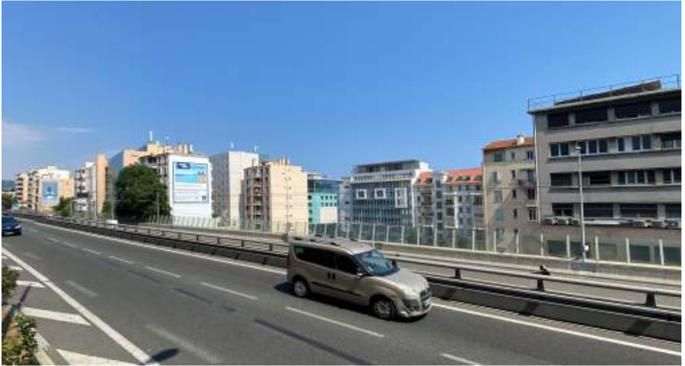
Vue depuis la voie Mathis :
