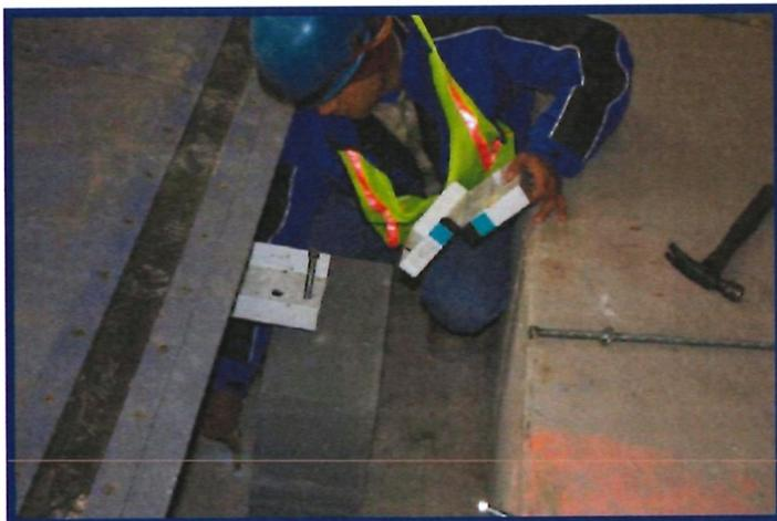
Positionner les tiges filetées inox  $\varnothing 13\text{mm}$  dans les trous et frapper les à l'aide d'un marteau afin de casser les capsules et libérer l'époxy de la capsule.
