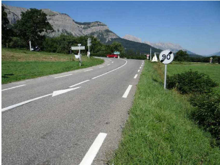
Vue sur le carrefour entre la RN85 et la D14 (secteur 1)
