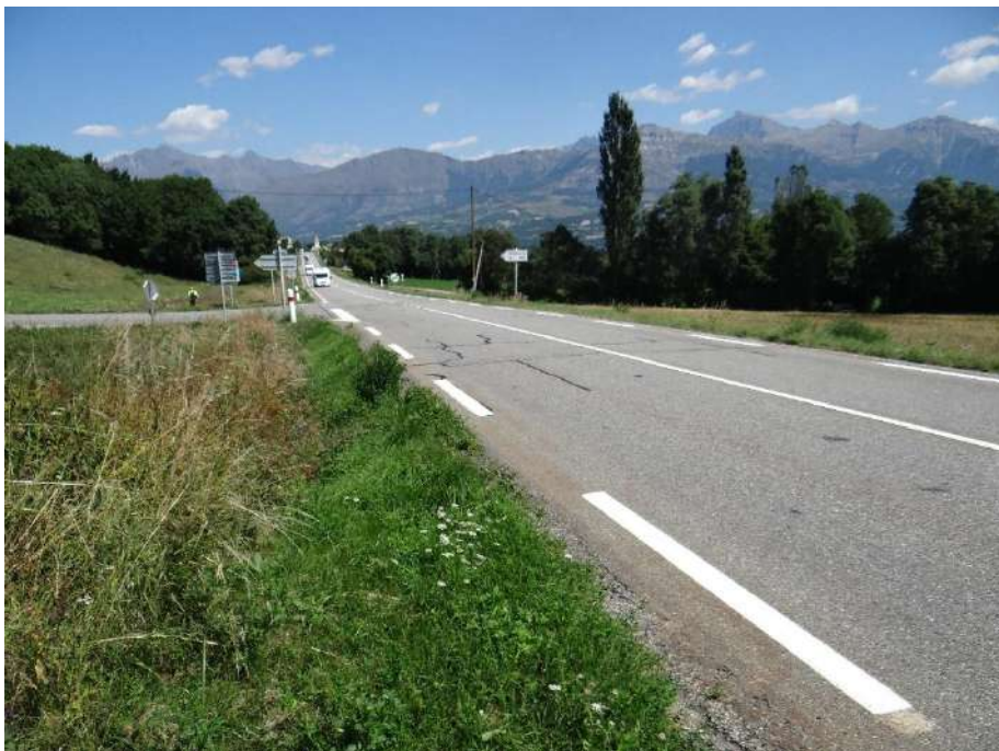
Vue sur le carrefour entre la RN85 et la D88 (secteur 2)
