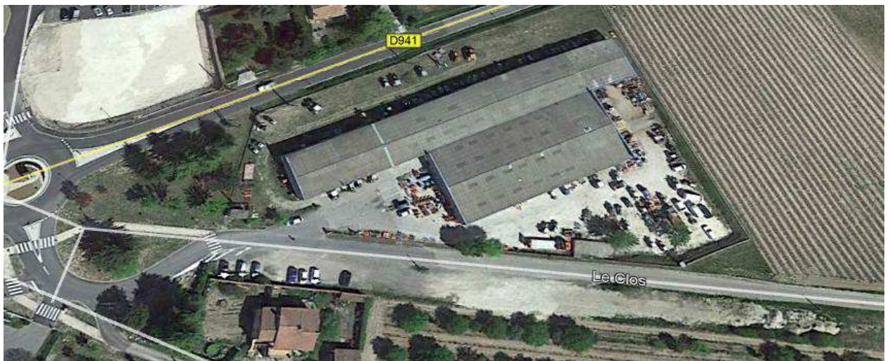
Image n°1 : Photographie aérienne du site (Googleearth ©)
