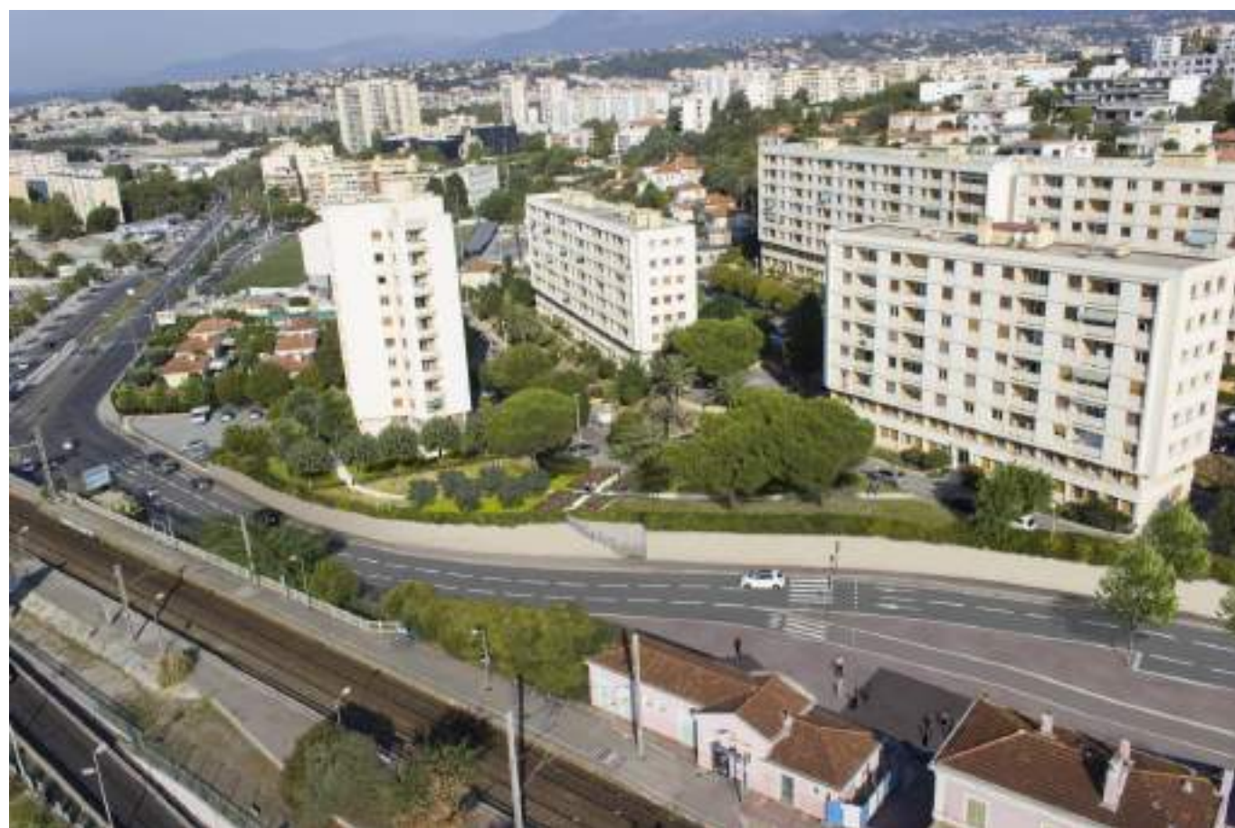
Insertion paysagère des travaux sur l'avenue Edouard Grinda
