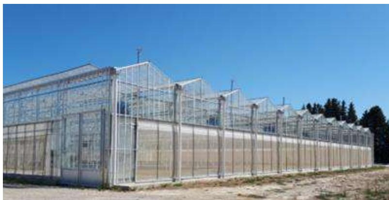
*Aération par filet/bâche armée sur enroulement*
