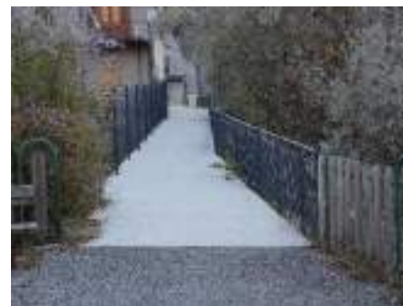
Chemin existant jusque sur la digue en sortie de village
