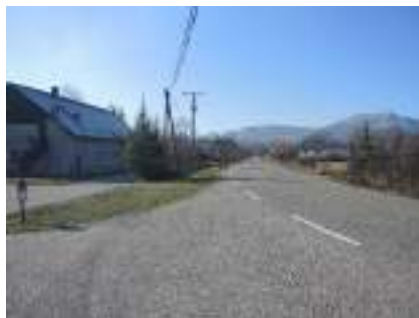
Le cheminement peut se faire sur la surlageur de la RD jusqu'au Pont de Chabottes
