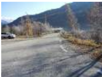
Raccordement sur la route départementale a niveau des Ricous. Traversée du Drac sur le pont à gué
