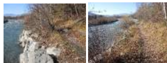
Le bord du Drac et à sécuriser sur environ 200 ml
