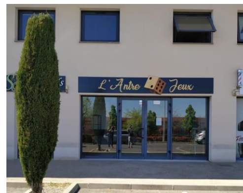
Enseigne bandeau dans le gabarit de l'entrée
