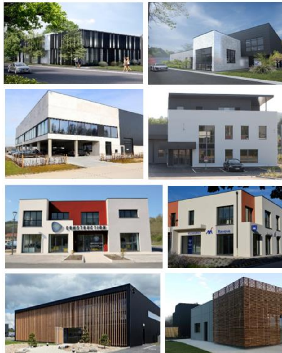
Exemples de bâtiments utilisant 2 matériaux et 2 coloris
