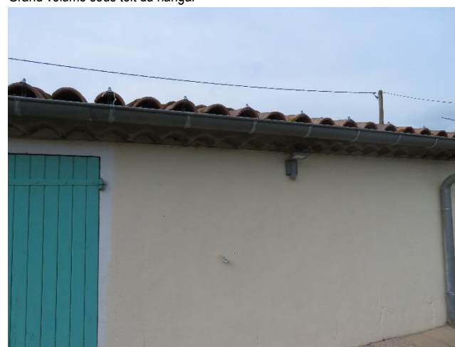
Espace sous tuiles
