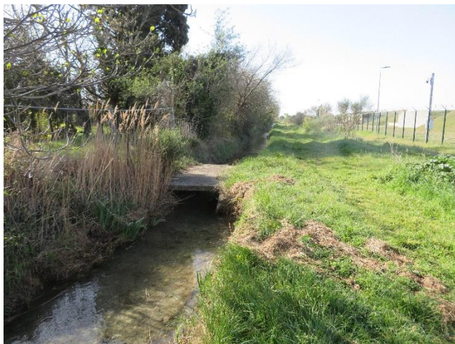
Canal de Fos-sur-Mer utilisé pour le transit principalement Photo prise dans la zone d'étude – ECOTER, 2021
