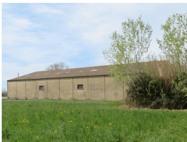
CV 17 : Bâtiment agricole isolé
