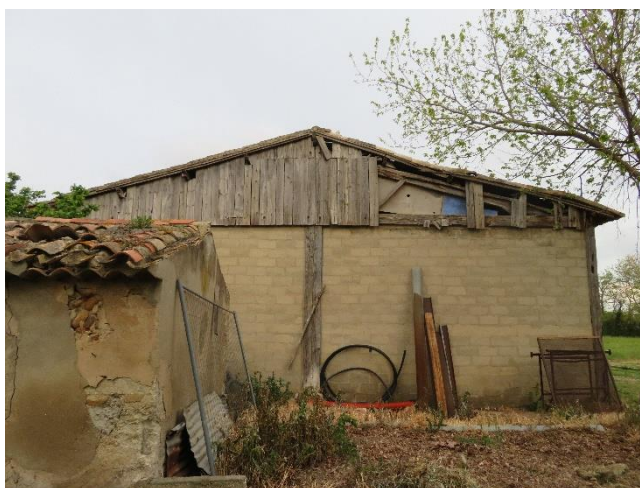
Toiture ou charpente
