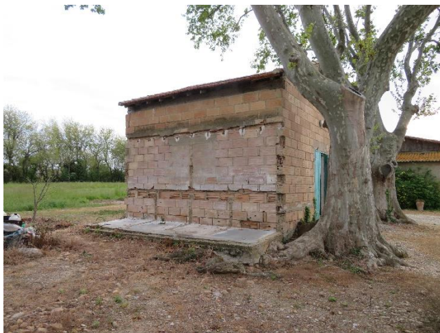
Allée de platanes favorables au gîte (Mas du Retortier) Photos prises dans la zone d'étude – ECOTER, 2021
