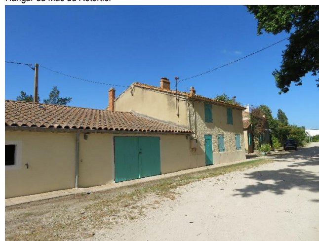
Toitures des bâtiments habités du Mas du Retortier
