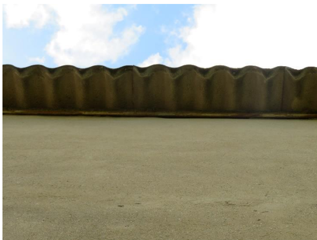
Interstice le long de la façade
