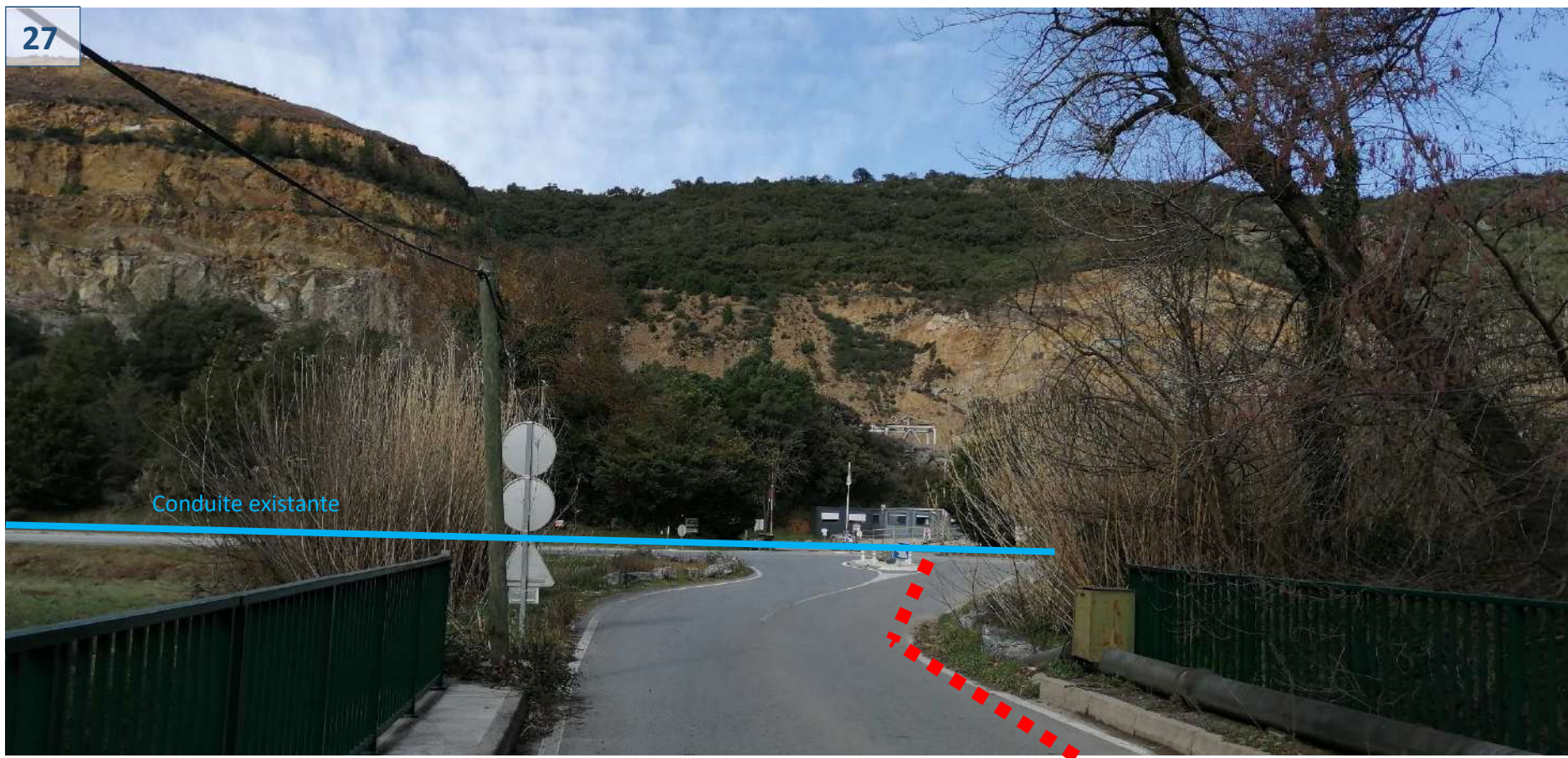
Photo 27 : canalisation de l'interconnexion passant en encorbellement sur le pont de l'Ecopôle franchissant la Môle et passant sous voirie jusqu'à la RN98
