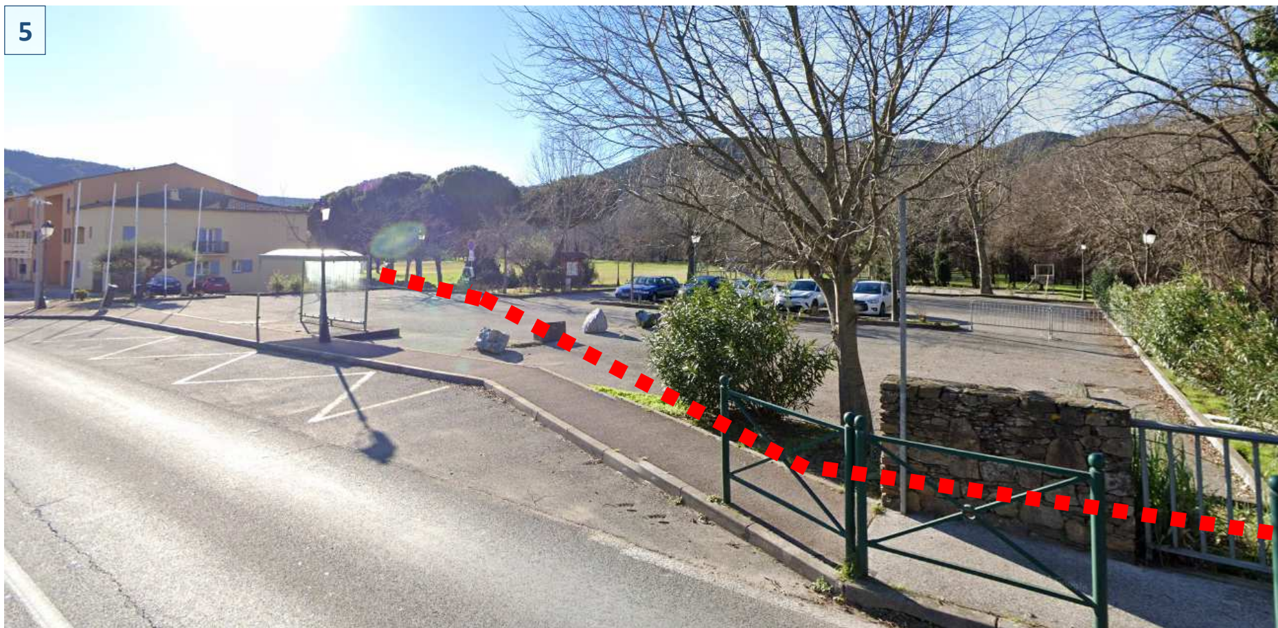
Photo 5 : Tracé de la conduite à la sortie du pont de la RN98
