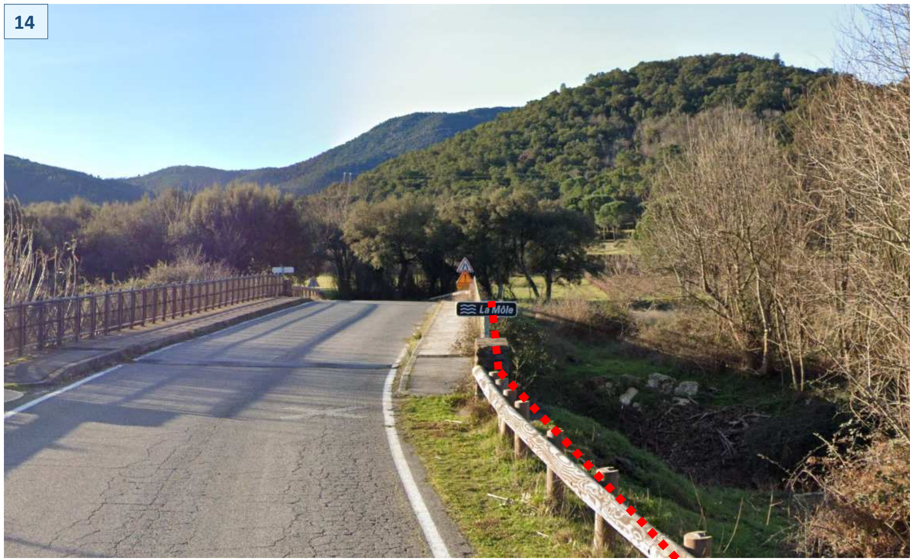
Photo 14 : Traversée de la Môle en encorbellement sur le pont de la RD27
