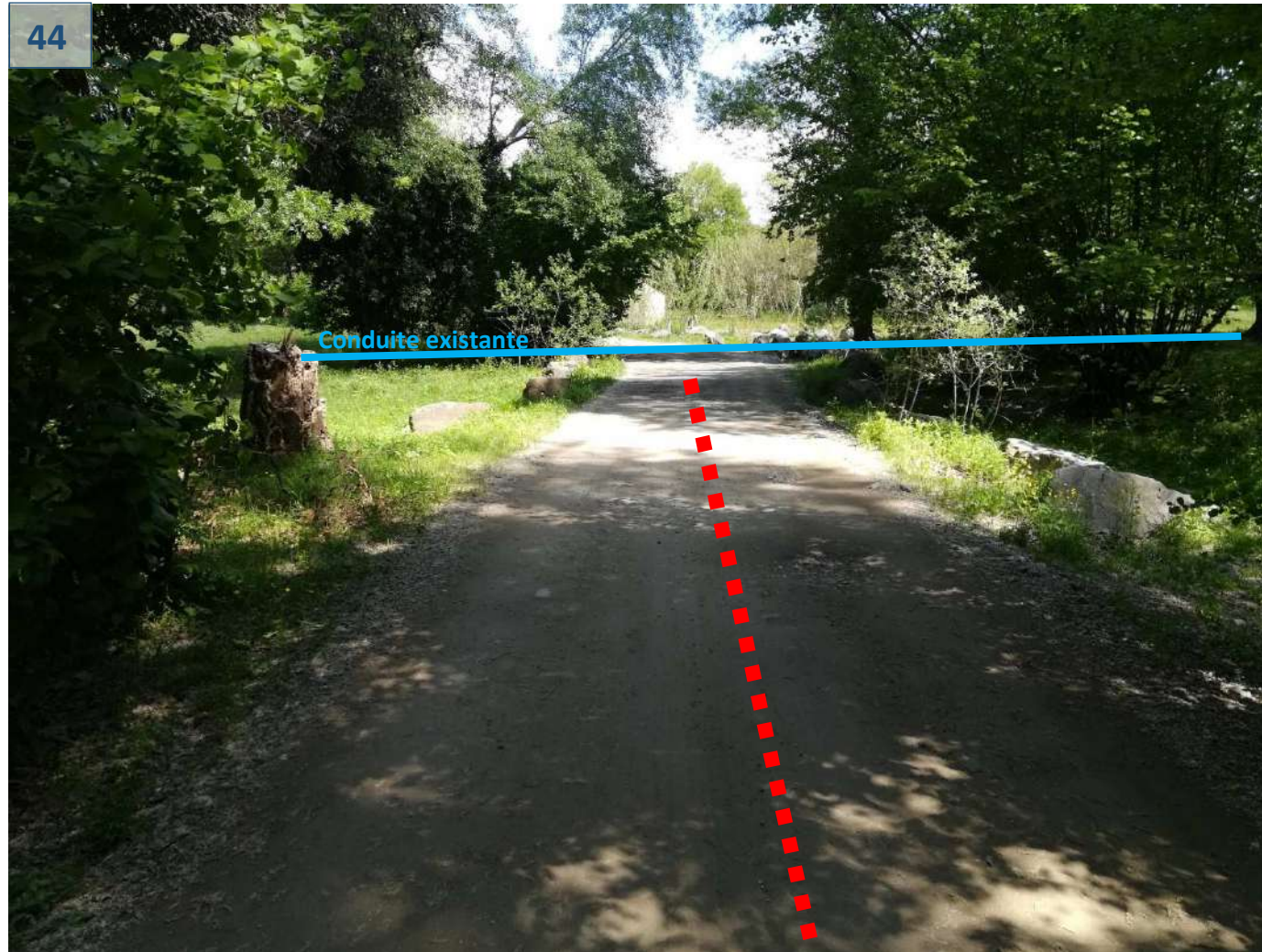
Photo 44 : Interconnexion dans le secteur du Val d'Astier : passage sous chemin DFCI
