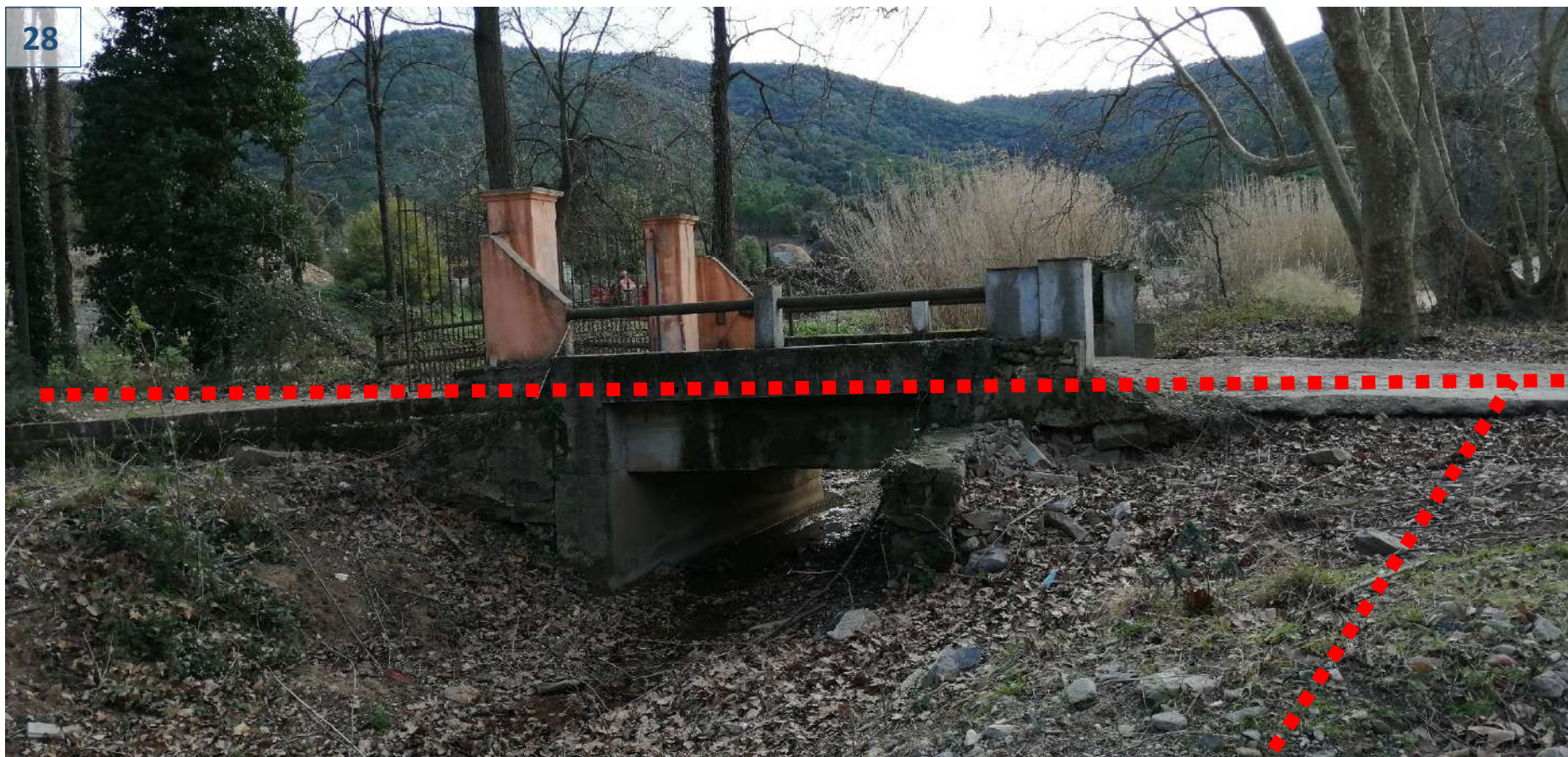
Photo 28 : Traversée en encorbellement du ruisseau du Maravéou et interconnexion 1
