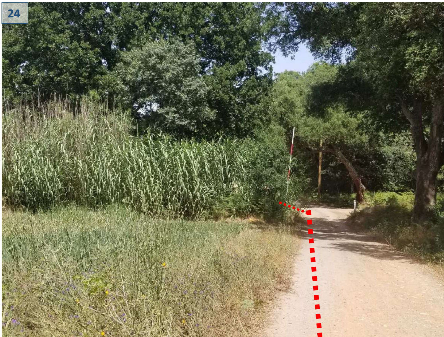
Photo 24 : Passage sous chemin DFCI au droit d'un ruisseau sans nom busé
