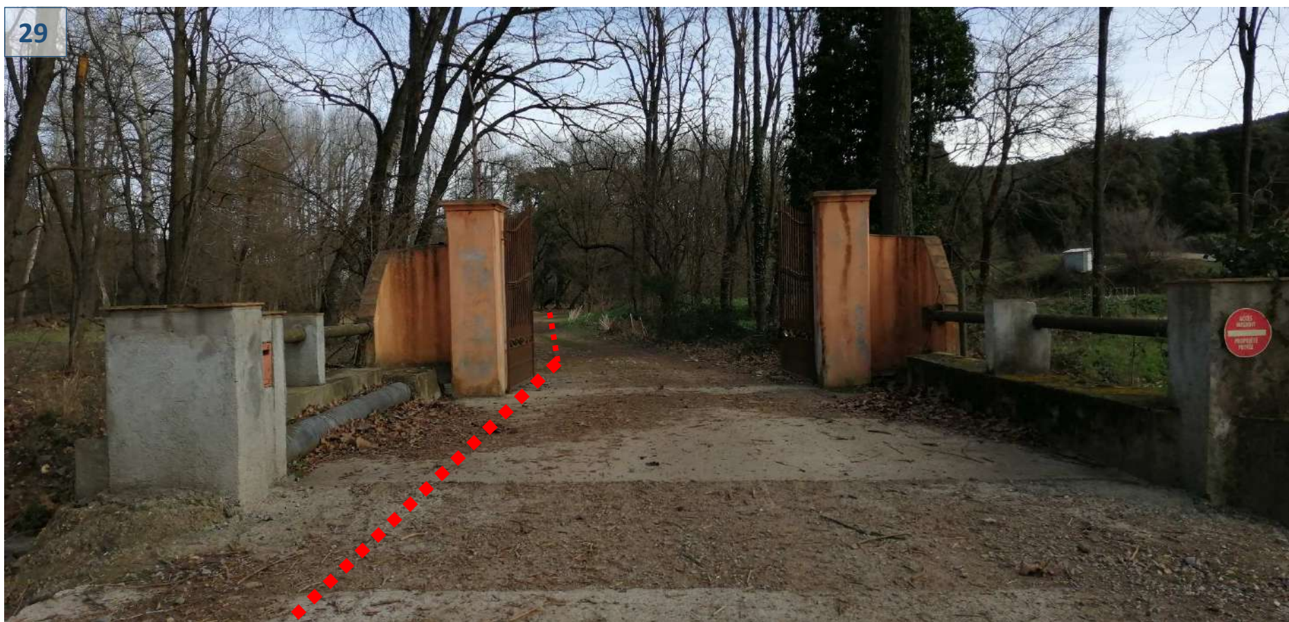
Photo 29 : Traversée en encorbellement du ruisseau du Maravéou
