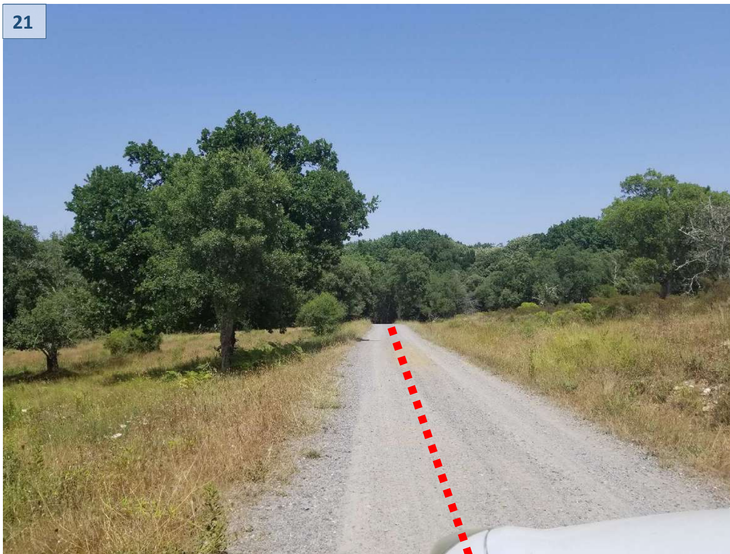
Photo 21 : Passage sous chemin DFCI dans secteur forestier éclairci
