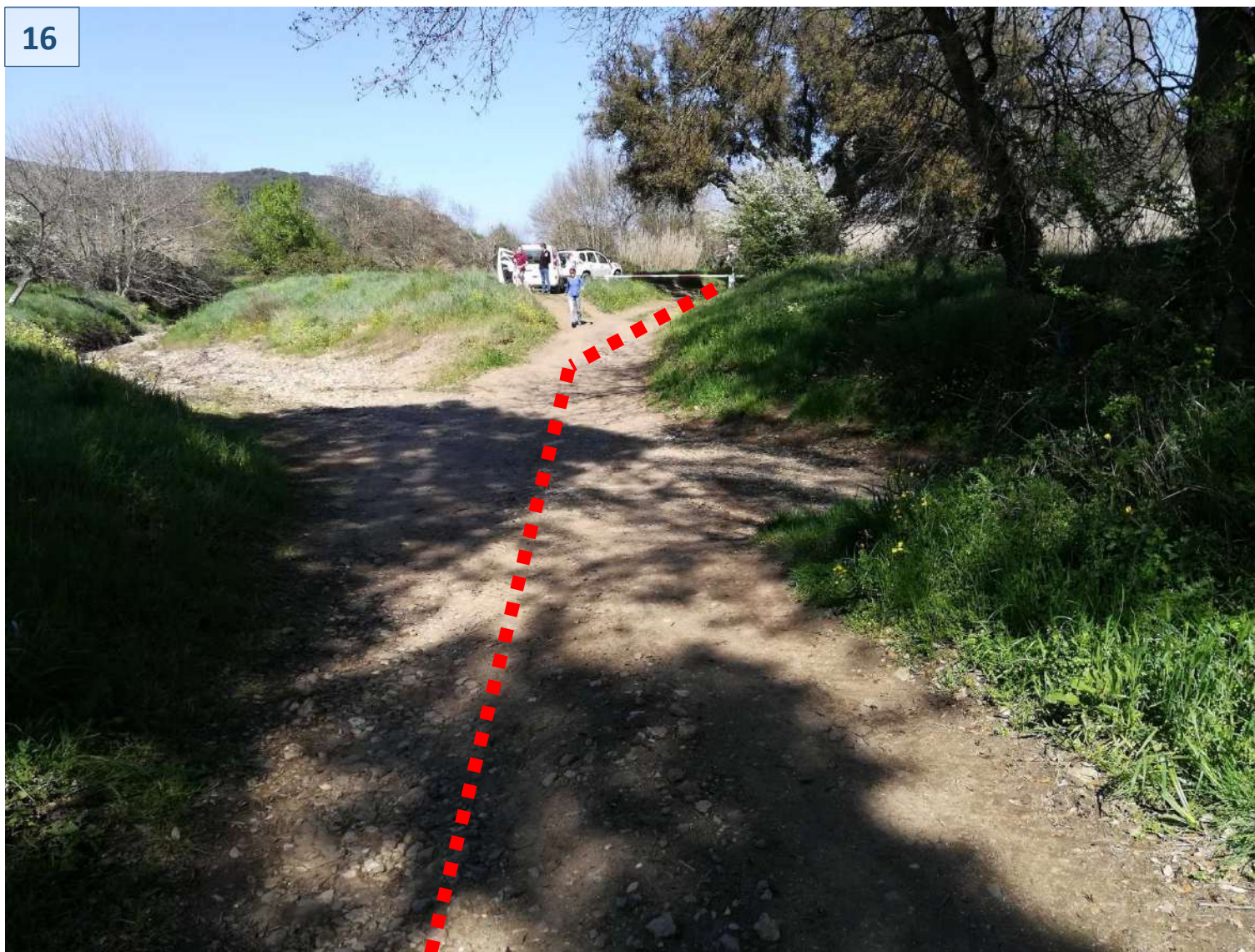
Photo 16 : Traversée du ruisseau assec du Carian (passage à gué DFCI) en tranché ouverte
