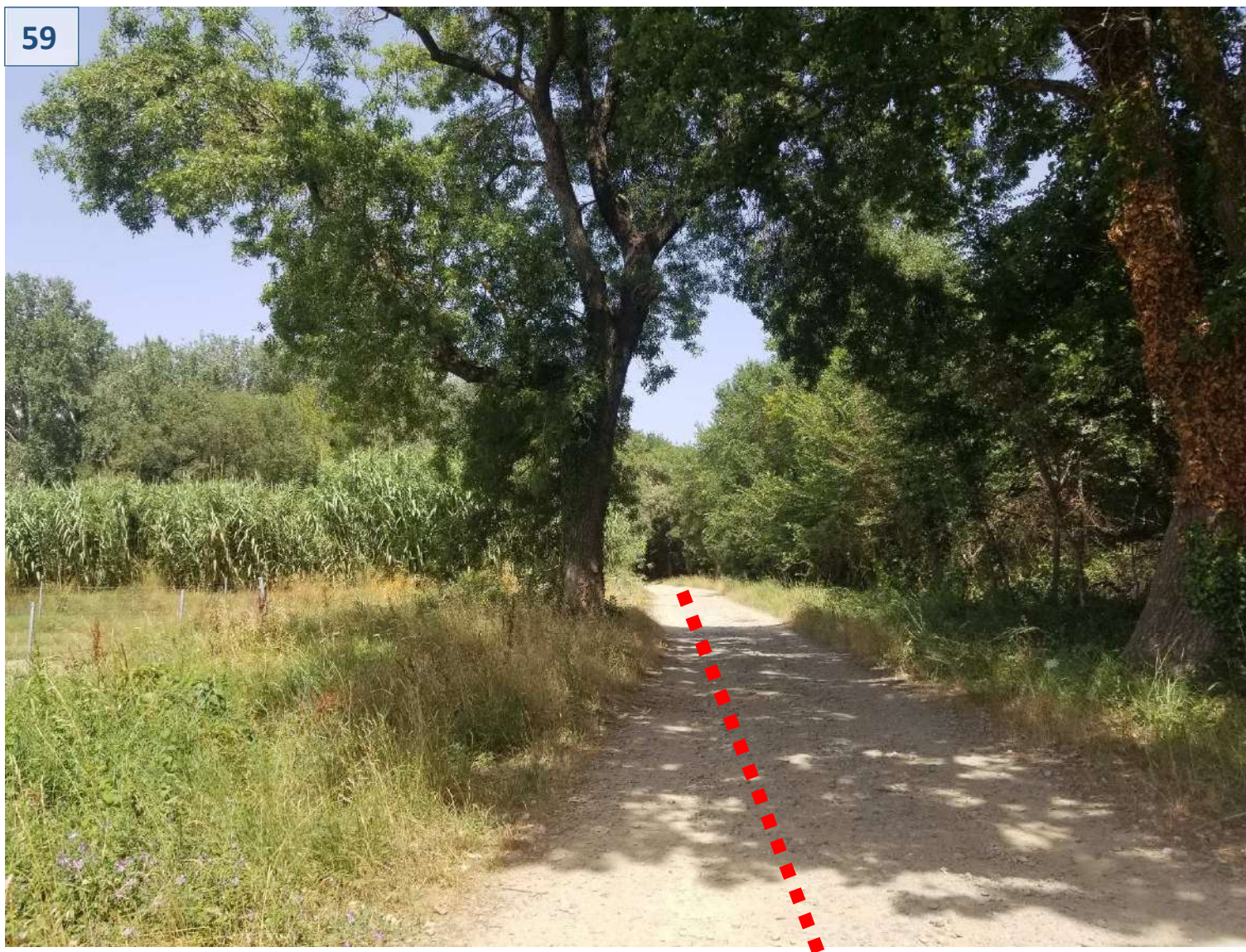
Photo 59 : Passage sous chemin DFCI
