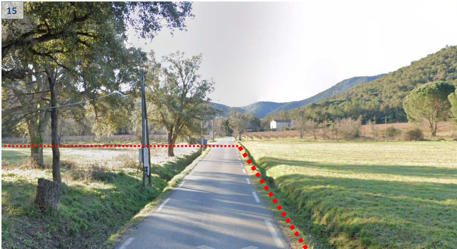
Photo 15 : Tracé de la conduite jusqu'au croisement du chemin DFCI
