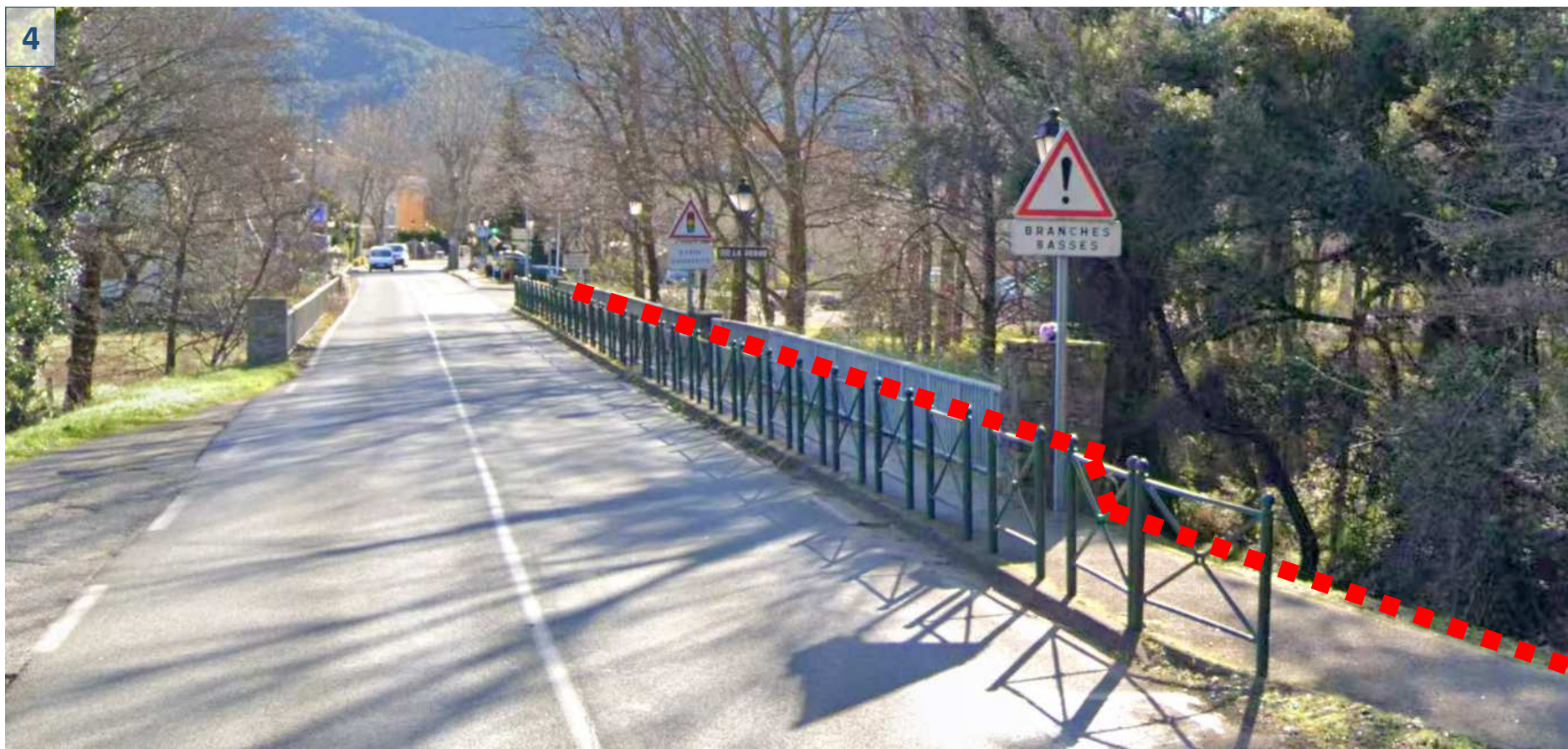
Photo 4 : Passage en encorbellement sur le pont de la RN98 franchissant la Verne
