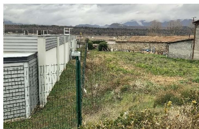
Photo 06 Source: LIDL Vue depuis la RD4085
