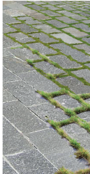
Pavés joints enherbés
