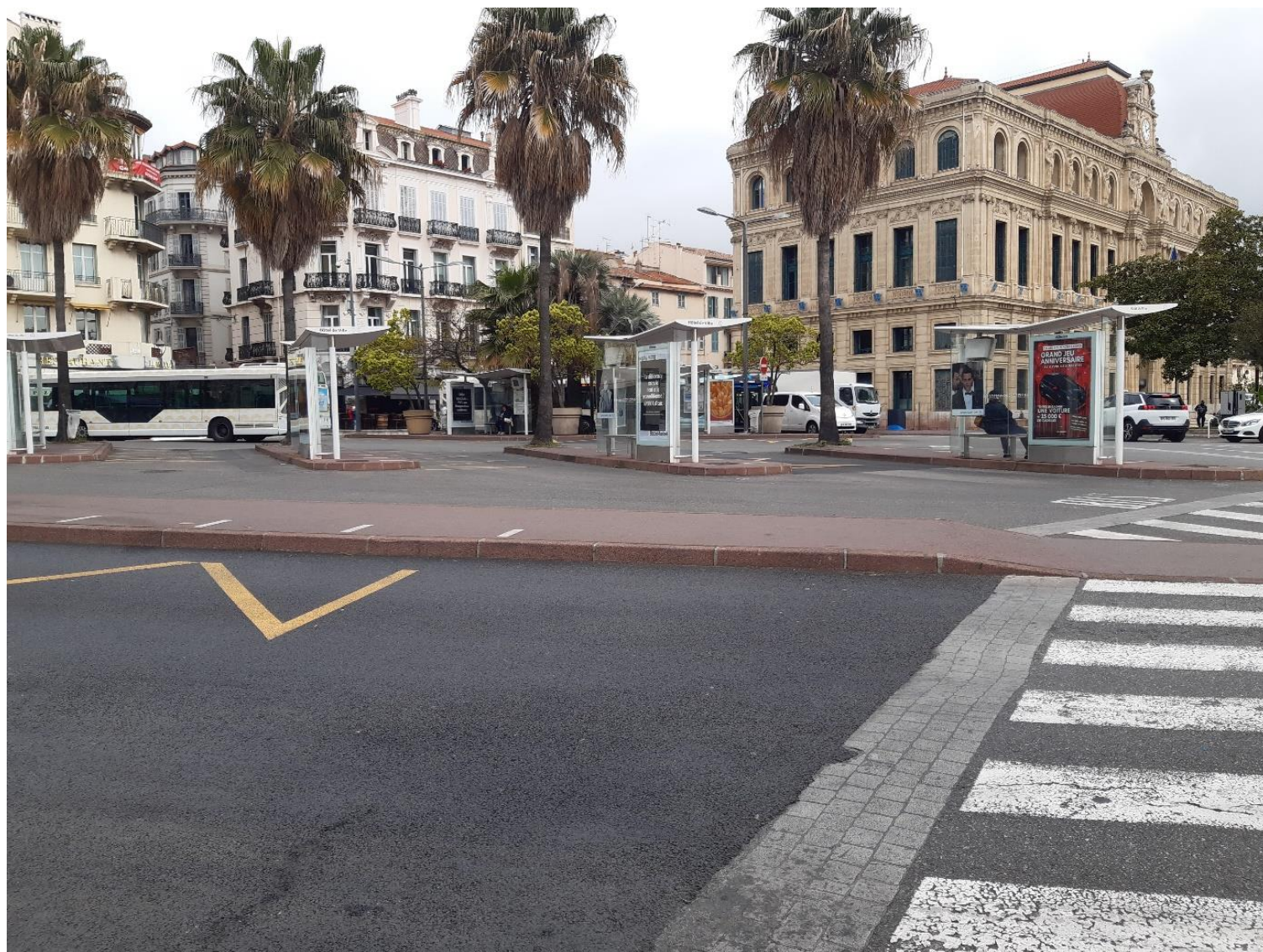
Photo 3 : Emplacement du futur puits d'attaque «Gare des bus » (photo prise le 22 avril 2022)
