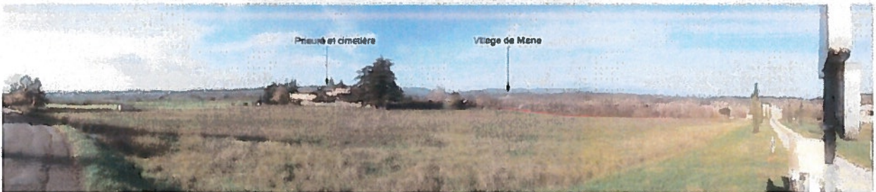
Vue 3 depuis la RD 316 (bordure du lotissement de la Burlière)
