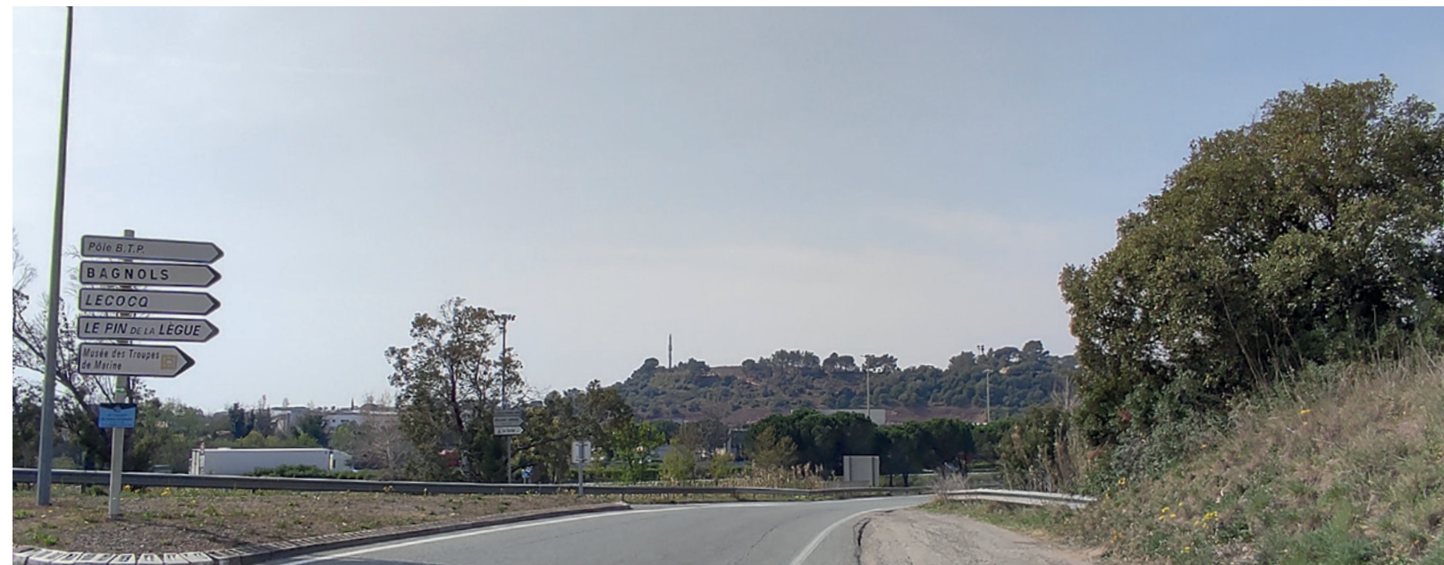
L'antenne vue depuis la Rue du Caporal El Hadj Houidef au Nord de l'autoroute A8
