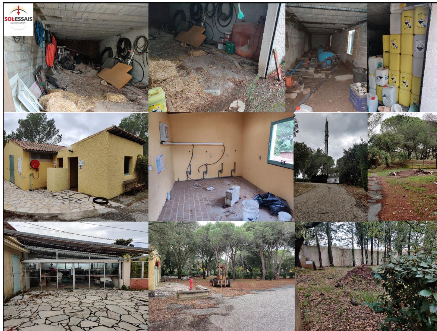
Figure 8 : Photographies de la visite de site (septembre 2021) - 3
