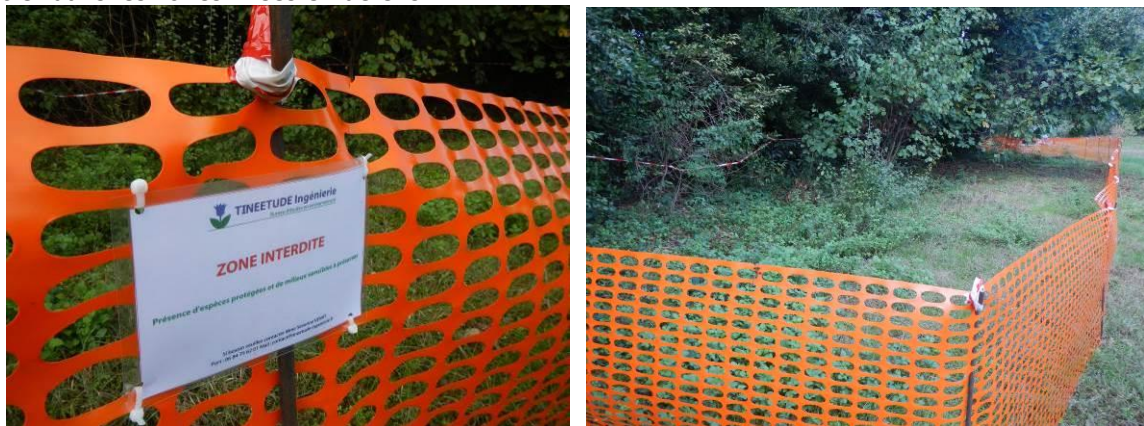
Exemple de moyen de mise en défens
