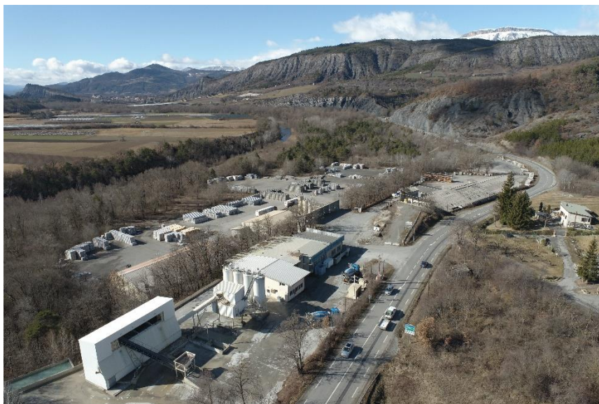
Figure 2 : Photographie de la vue aérienne du site de Tallard
