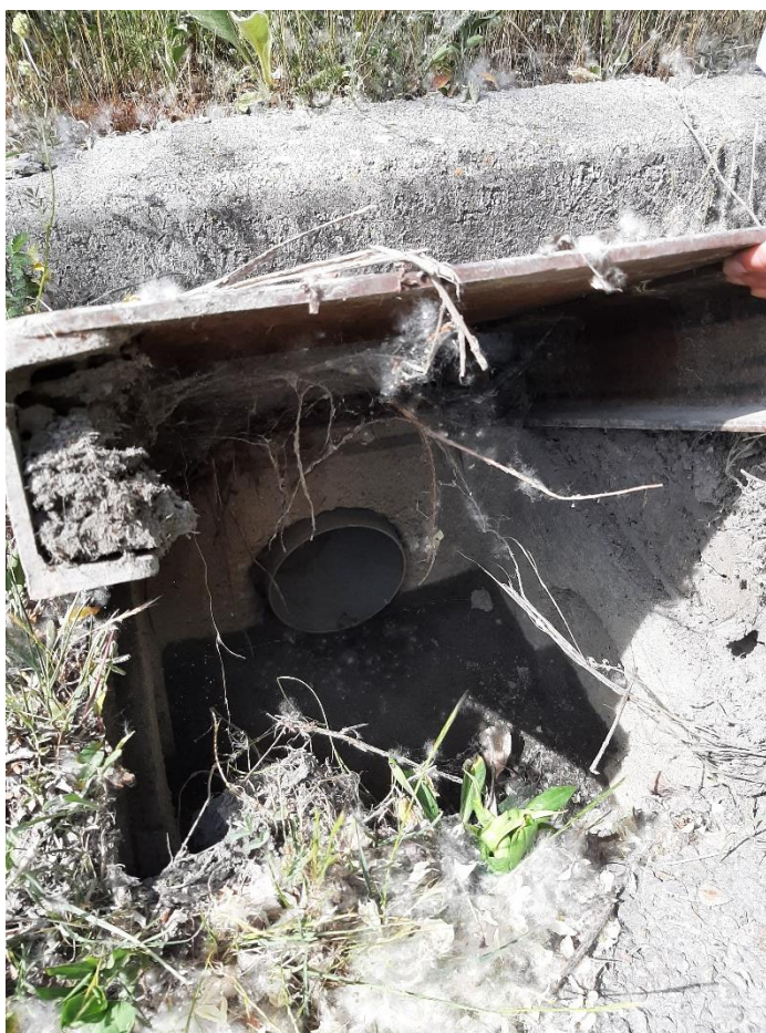
Figure 10 : Photographie du regard présent sur le site
