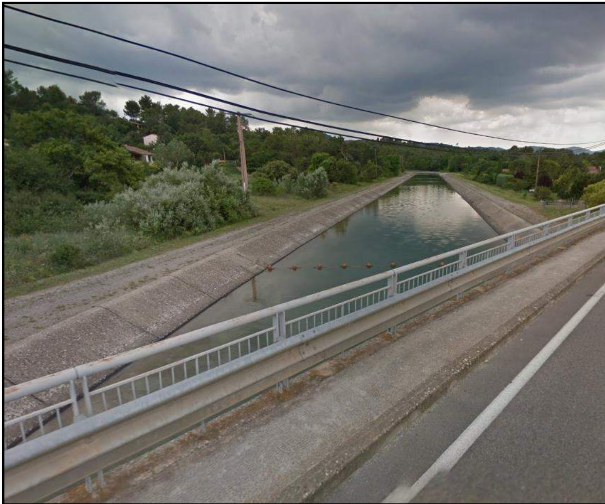
Photo 1 – Canal Maitre II – vue proche, Google Maps, juin 2018
