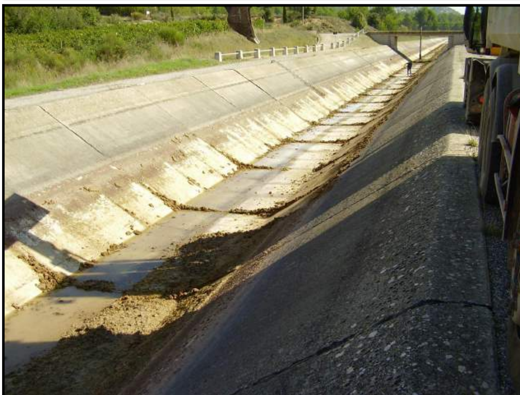
Photo 6 – Curage du canal Pigoudet – vues proches, SCP, octobre 2005
