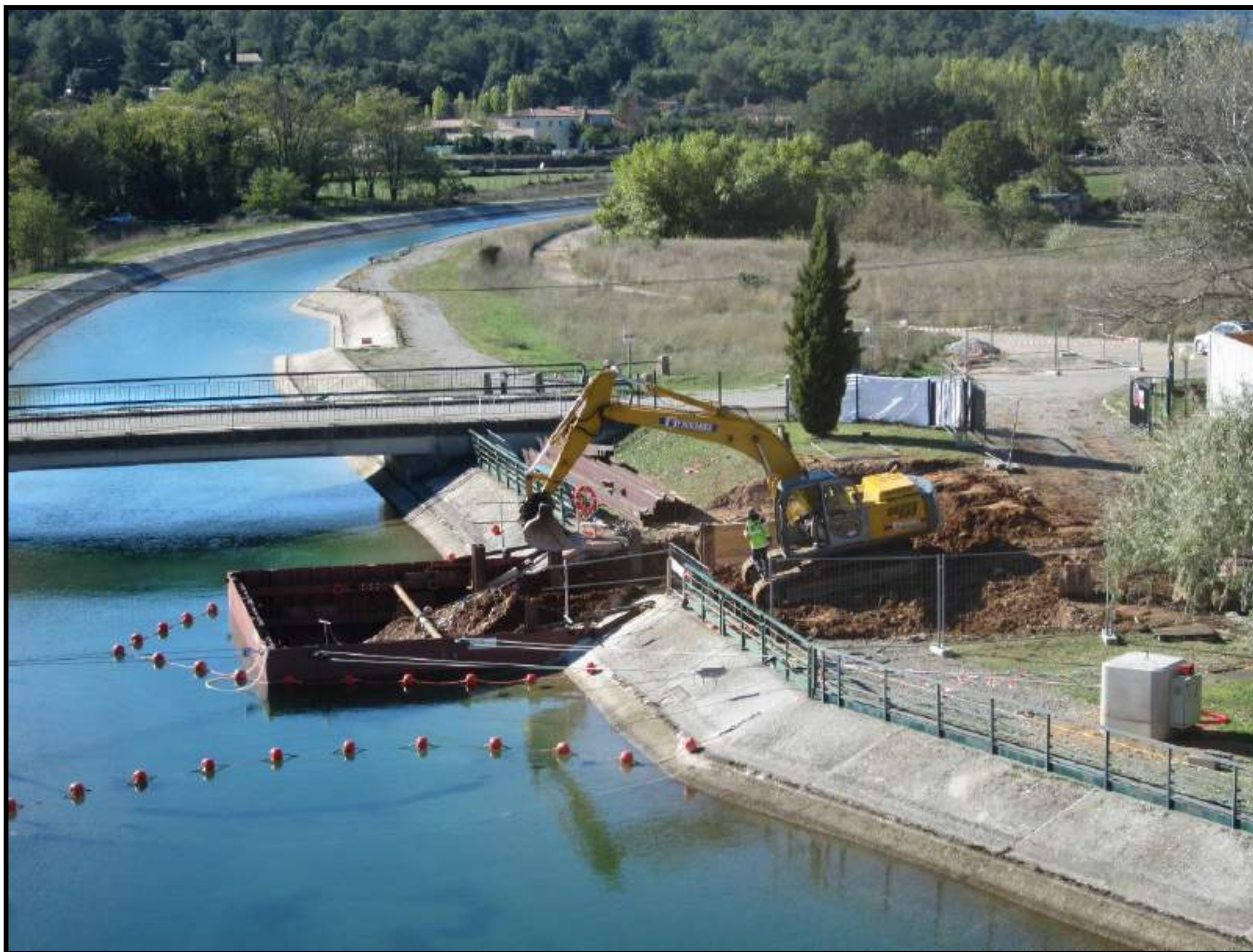
Photo 2 – Travaux sur le canal Maitre II – vue proche, SCP, mai 2012
