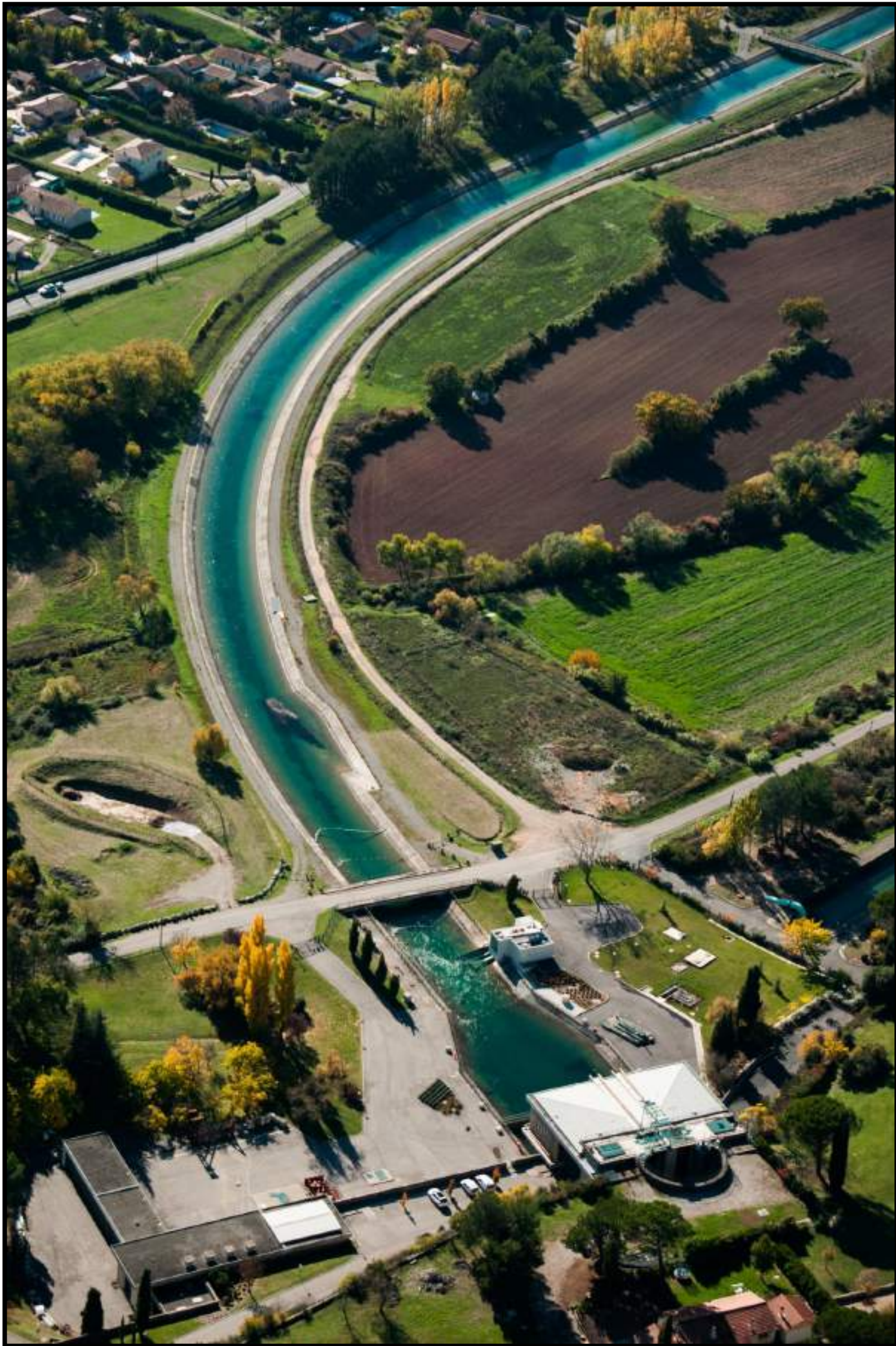
Photo 4 – Départ du canal Maître II – vue lointaine, SCP, octobre 2015
