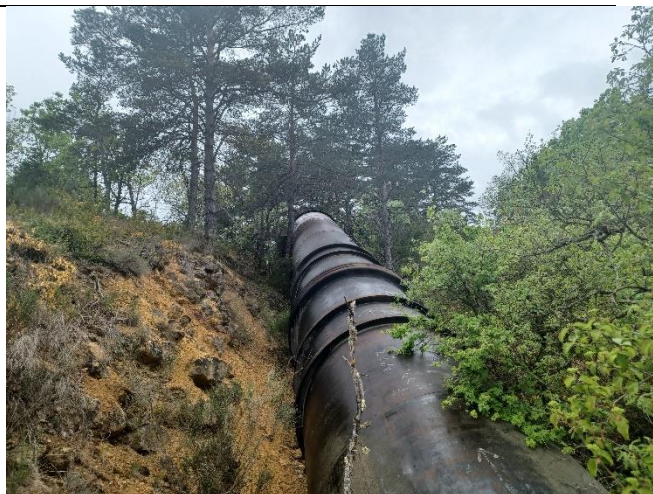
Photo 14 : Vue du siphon de Malaurie
