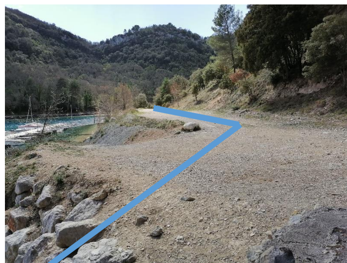
Photo 4 : Vue de la remontée sur la piste et pose sous la piste existante
