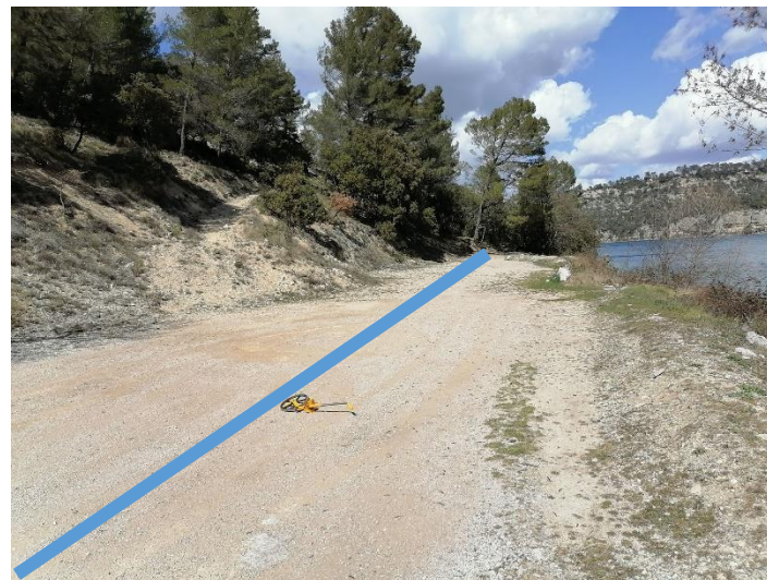
Photo 6 : Vue de la piste existante sous laquelle la conduite principale va être posée
