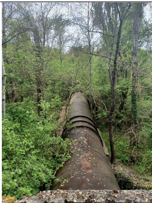
Photo 17 : Vue du siphon de Malaurie
