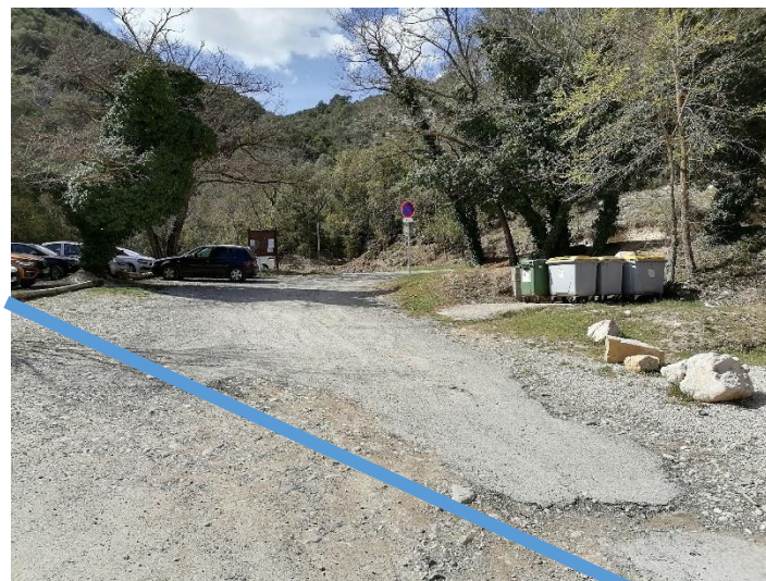
Photo 12 : Vue du parking existant concerné par la pose de la conduite principale
