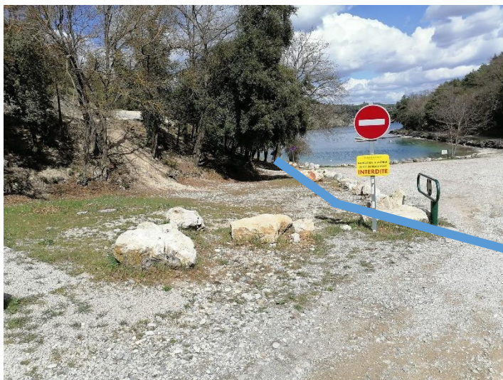
Photo 11 : Vue du parking existant concerné par la pose de la conduite principale
