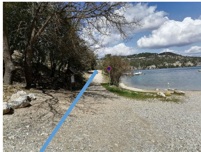
Photo 10 : Vue de la piste existante sous laquelle la conduite principale va être posée
