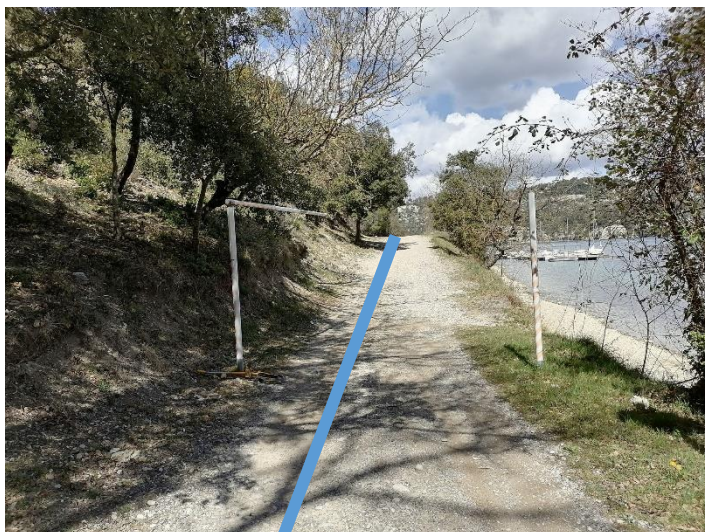
Photo 7 : Vue de la piste existante sous laquelle la conduite principale va être posée
