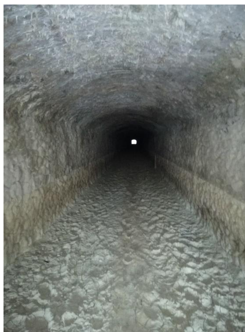
Vue du tunnel des Marlines
