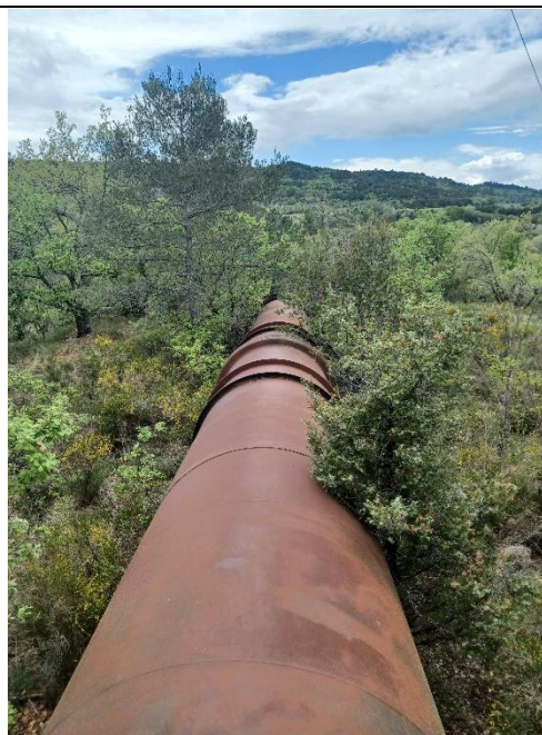
Photo 18 : Vue du siphon de Malaurie
