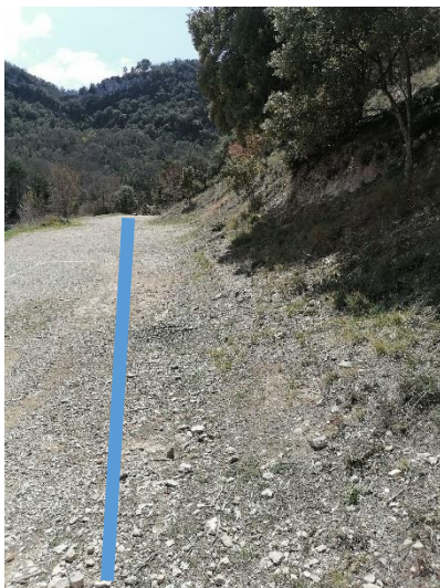
Photo 5 : Vue de la piste existante sous laquelle la conduite principale va être posée
