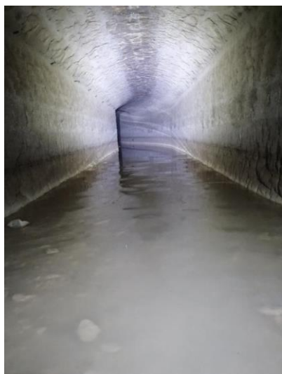
Maçonneries amont (PM340)
