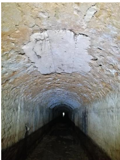
Tronçon maçonneries aval (PM3890)
