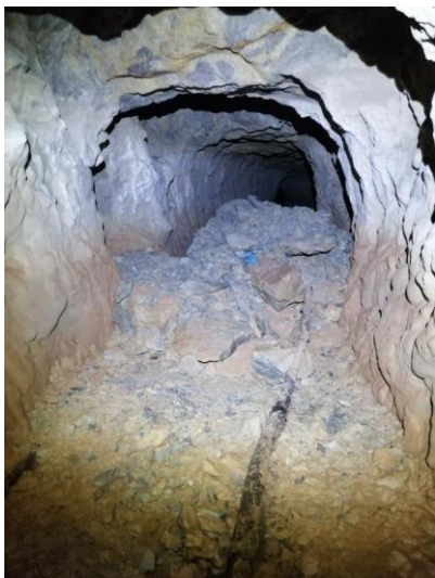
Rocher altéré éboulement important (PM2770)
