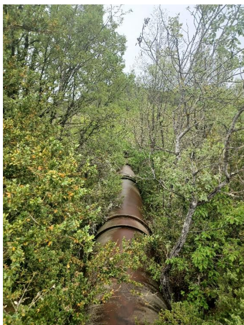
Photo 15 : Vue du siphon de Malaurie
