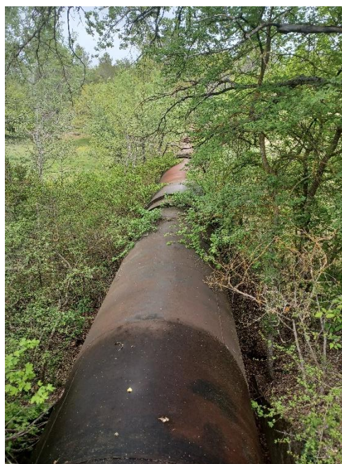
Photo 16 : Vue du siphon de Malaurie
