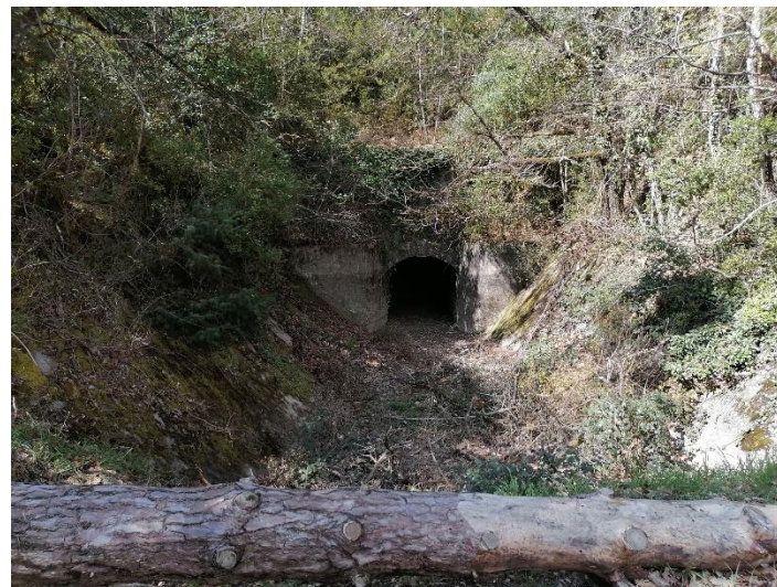
Photo 14 : Vue de la partie de l'ancien canal qui sera utilisée en amont immédiat de l'extrémité amont du souterrain des Maurras ainsi que de l'extrémité amont du souterrain des Maurras
