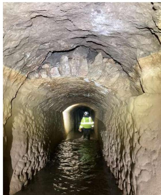
Figure 8 Début section maçonnée PM 600
