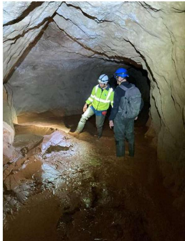
*Figure 19 Dépôt argileux PM 950*
