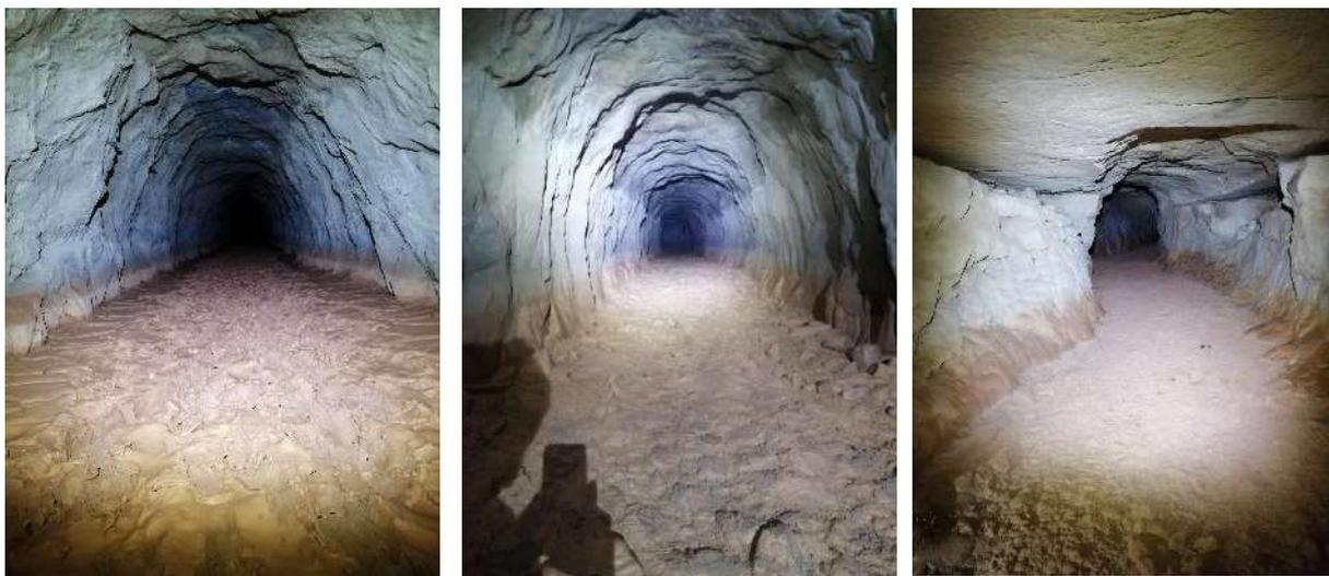
Photos dépôts argileux en radier aux PM 680 – PM 1390 – PM 2100
