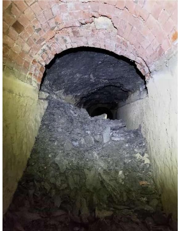
Figure 7 Briques en très mauvais état et éboulement
