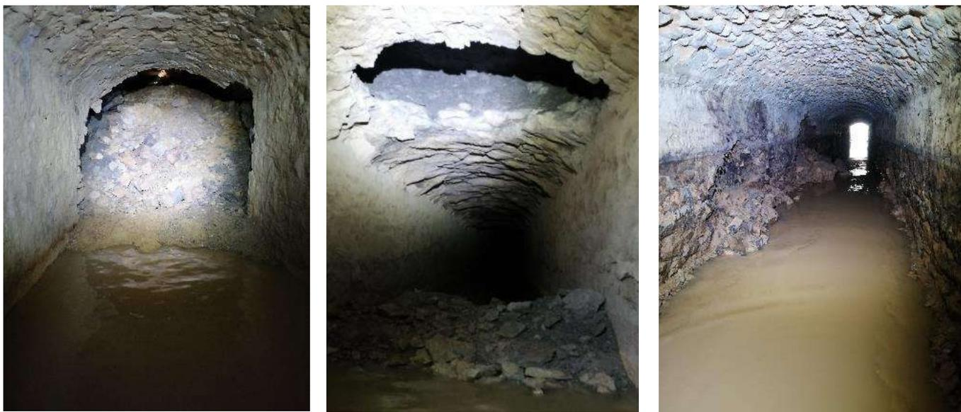
Photos des effondrements de maçonneries aux PM 12 – PM 66 – PM 4070
