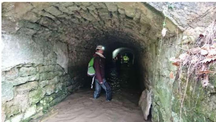
Photo 3 : zones maçonnées en entrée de tunnel
