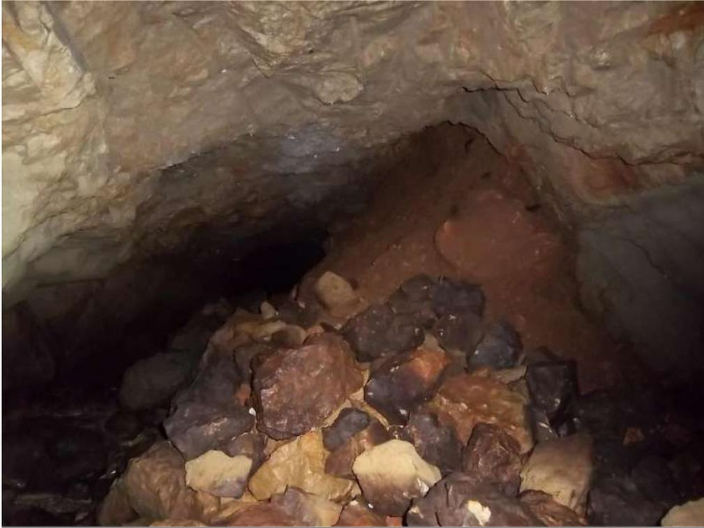
*Figure 16 Éboulement au niveau du puits 8 (2012)*
