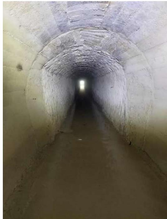
Figure 24 - PM150 passage à section maçonnée
