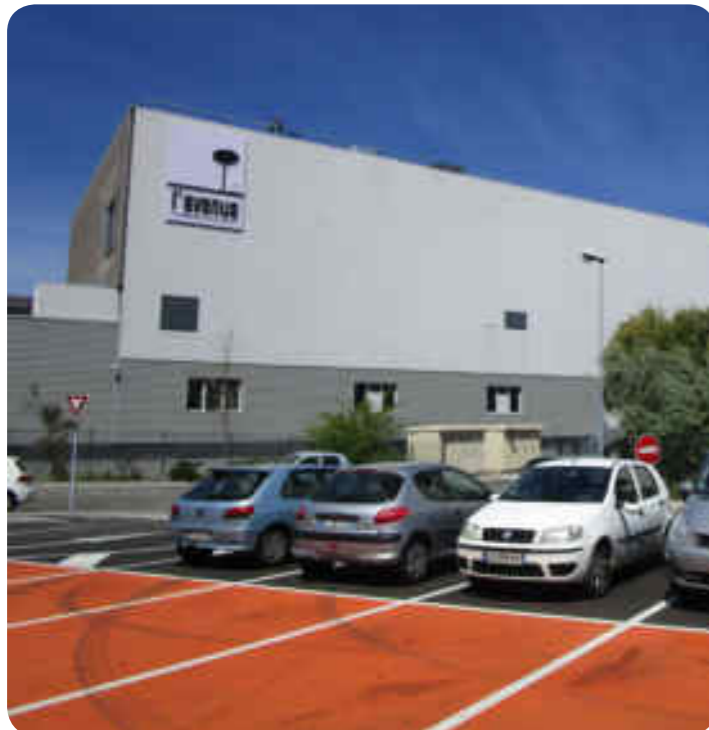
façade arrière d'Avenue 83 depuis le parking de Monsieur Meuble à l'est
