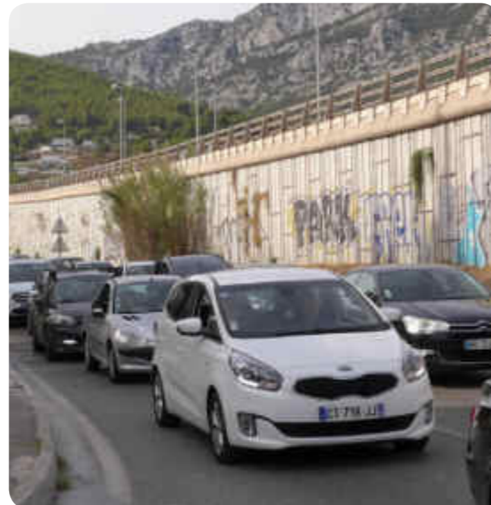
le mur de l'autopont
