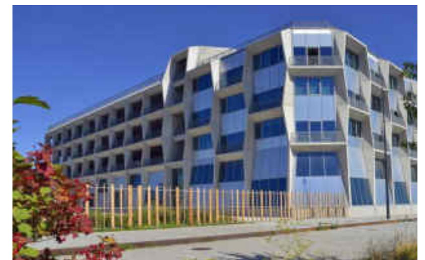
Ruche d'entreprise et parking silo de la Tossée, Tourcoing : bureaux et parking réversible (Tank architectes)
