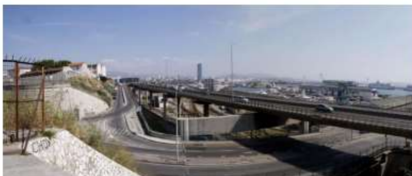
Figure 10 – Superposition d'infrastructures, la Zac est à gauche, le port à droite. La Corniche (cf. note 7) pourrait prendre place au niveau de la prise de vue (Source : présentation adressée aux rapporteuses).
