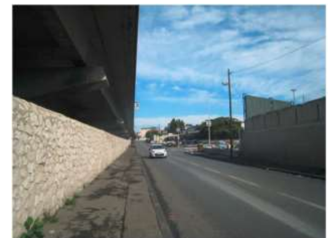
Chemin de la Madrague Ville au droit de la rue Allar
