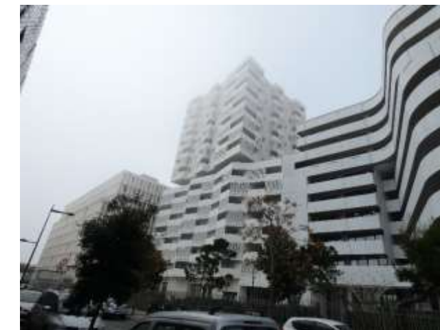
Bâtiments neufs soulignés de plantations récentes donnant sur la rue du Devoir
