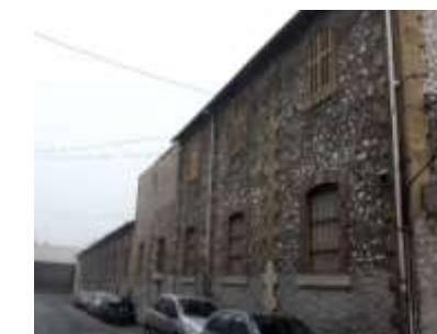
Anciens ateliers quartier des Crottes
