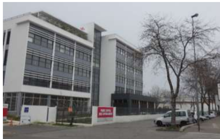
Immeuble du pôle d'activité Gèze
