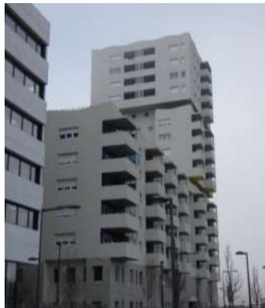
Bâtiment mixte habitat/activités donnant sur la rue Allar
