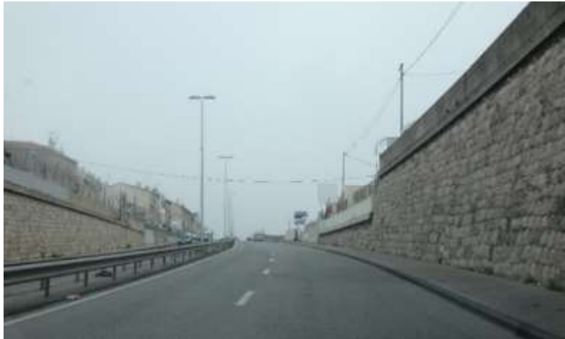
Entrée dans la ZAC Littorale par l'avenue du Cap Pinède
