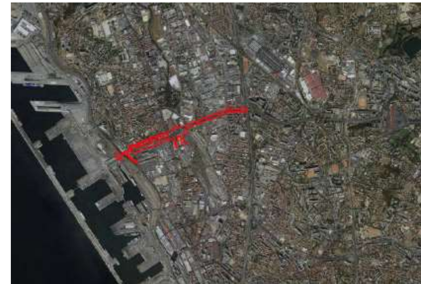
Vue aérienne actuelle du secteur d'étude, source Géoportail
