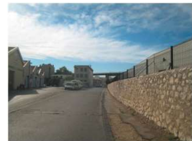
Intersection entre le chemin de la Madrague Ville et la rue Cazemajou
