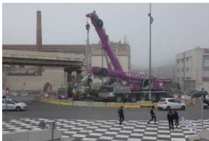
Vue depuis le PEM Gèze : démontage de la passerelle de Cap Pinède
