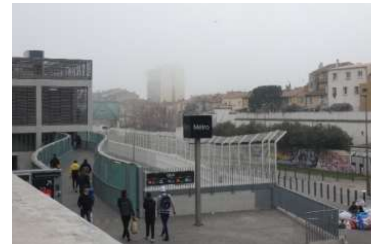
Partie médiane du PEM Gèze : entrée du métro
