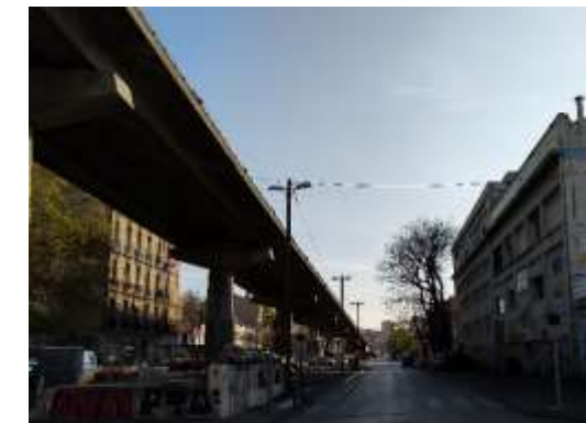
La passerelle de l'A557
