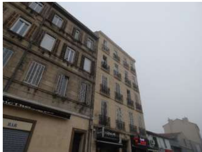
Immeubles de grande hauteur alternent avec des maisons de ville à un étage
