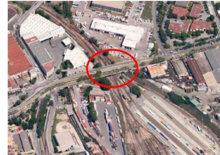
Passage supérieur du boulevard du Capitaine Gèze, source Etude de connaissance de l'aléa inondation sur le bassin versant des Aygalades
