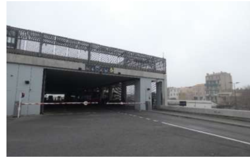
Partie supérieure du PEM Gèze : entrée de la gare routière
