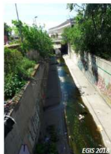
Ruisseau des Aygalades au droit du boulevard du Capitaine Gèze (point de vue 1)
