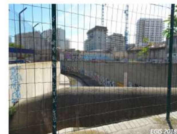
Ruisseau des Aygalades au niveau du boulevard de Briançon (point de vue 2)
