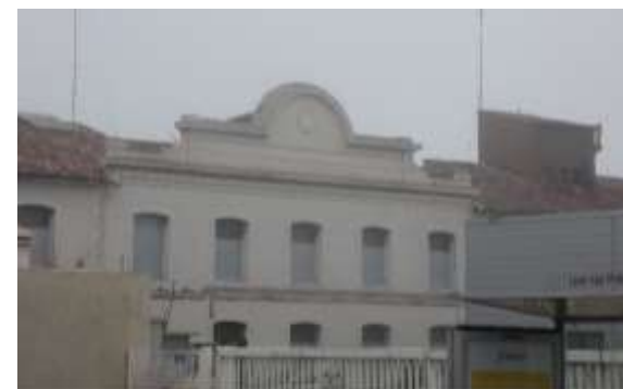
Bâtiment désaffecté de la gare du Canet, rue de Lyon
