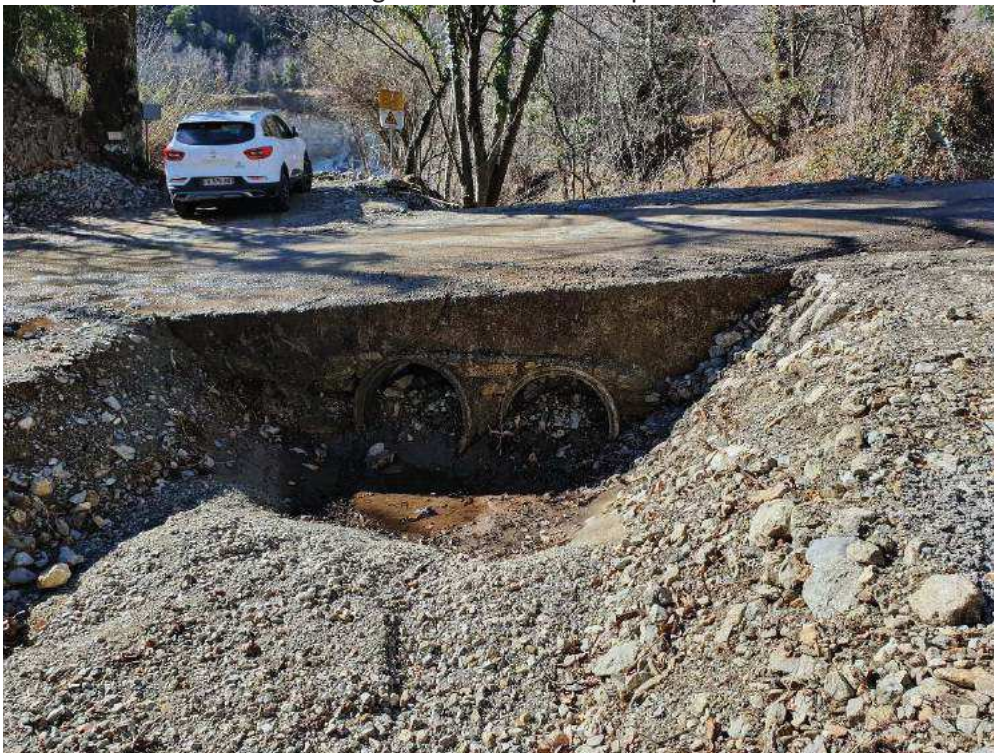
Figures 3 et 4 : Vallon du Touron - Passagé busé en aval à remplacer par un cadre béton
