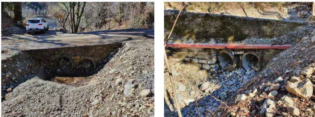
Buses DN800 – Franchissement de la voie communale de la Pinio
