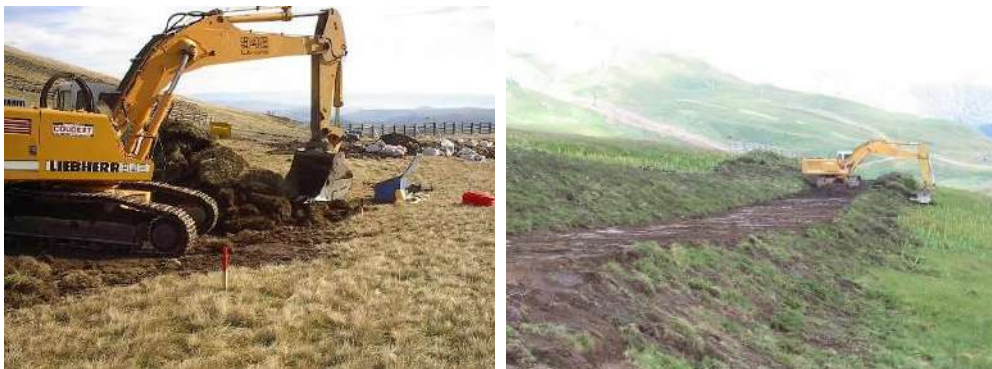
Photo 2 Exemple de stockage de mottes à la pelle mécanique en bordure d'emprise
