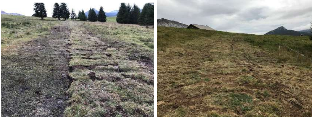
Photo 4 Etrépage : résultats de replaquage sur de travaux de réseaux sur le plateau des Glières (photos 2019 année des travaux)
