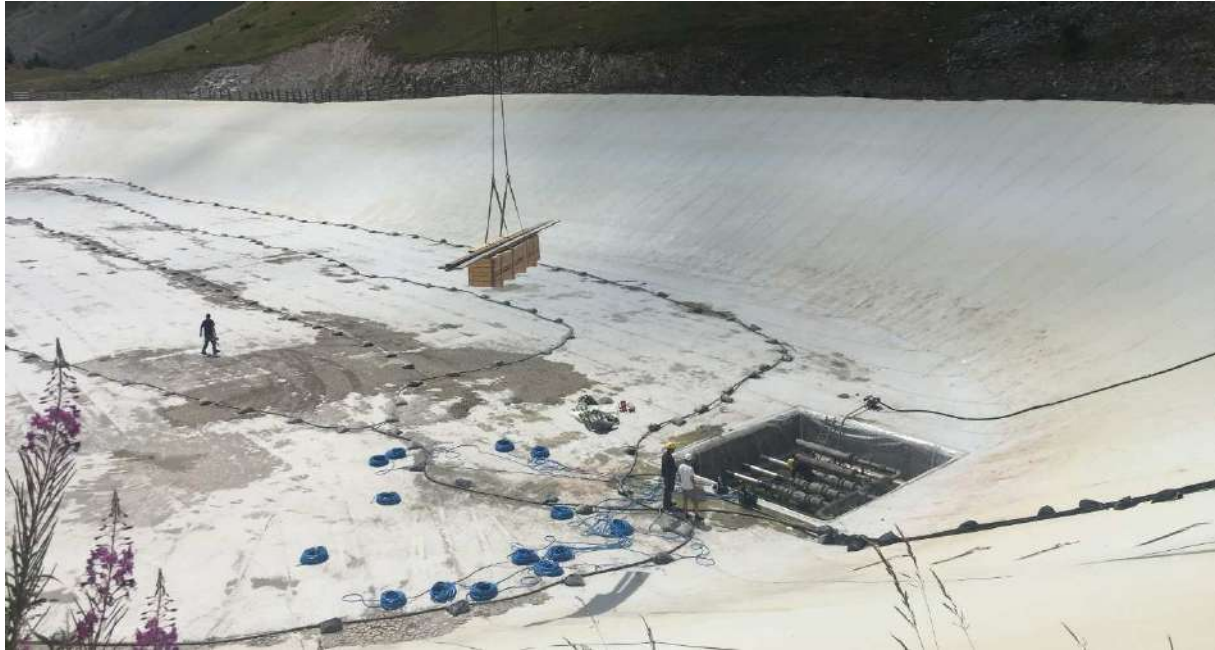
fig. 8. Opération de remplacement d'un pompe après vidange (Pélourenq 1, 2019)
