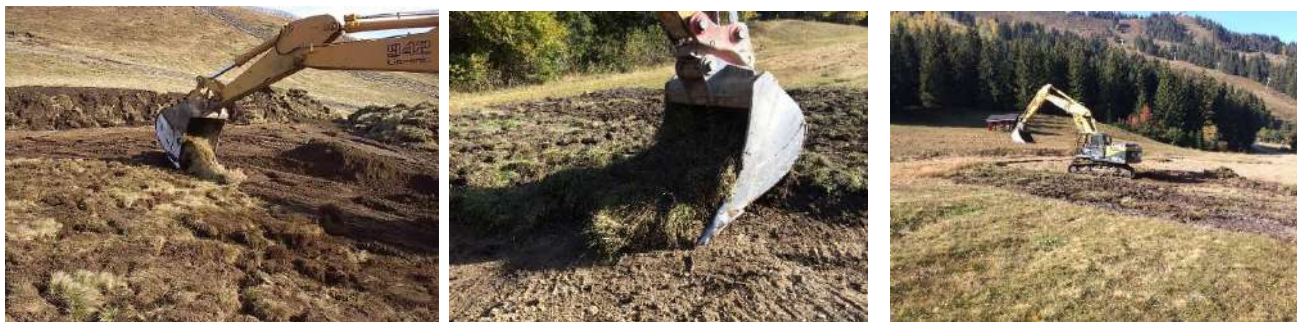
Photo 3 Exemple de remise en place de mottes à la pelle mécanique
