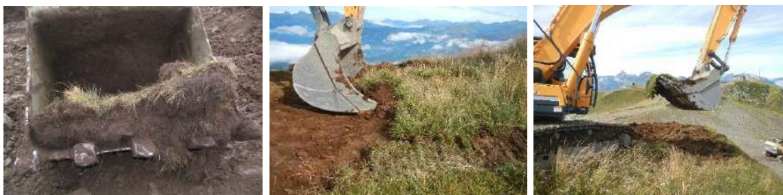
Photo 1 Exemple de déplaçage de mottes à la pelle mécanique et godet « classique »
