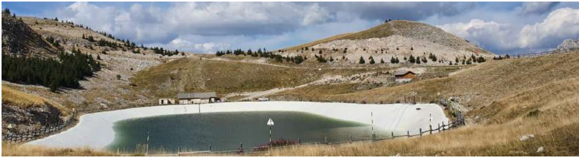
Photo 11 Retenue collinaire existante et bâtiments présents à proximité
