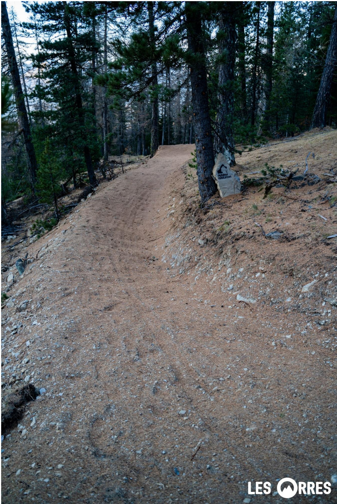
Figure 10 Exemple d'aménagement à la pelle mécanique en forêt
