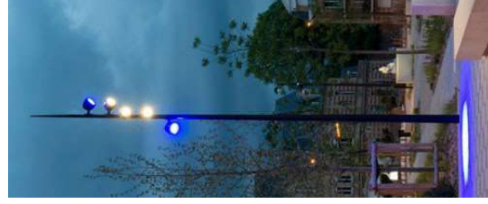
Mat aiguille multi-spots - mât cylindro conique aluminium (Valmont) spots Xéon Eclatec
